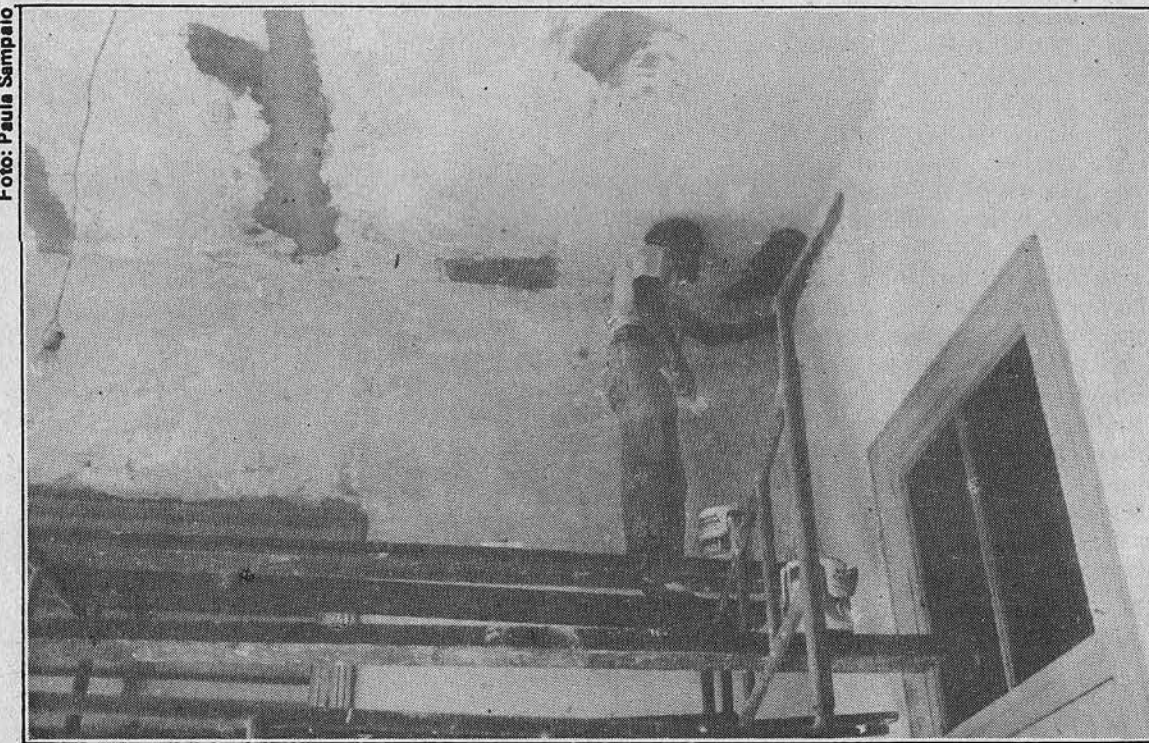
Em alguns campi, foram necessárias reformas nos prédios para o reinício das aulas.
