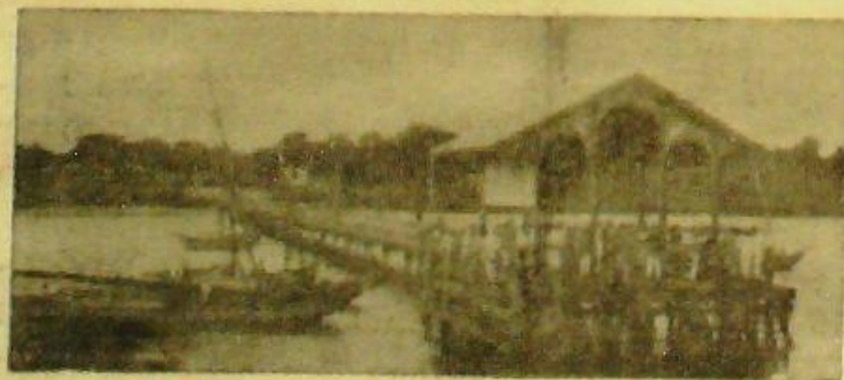
Ponte do Mosqueiro
