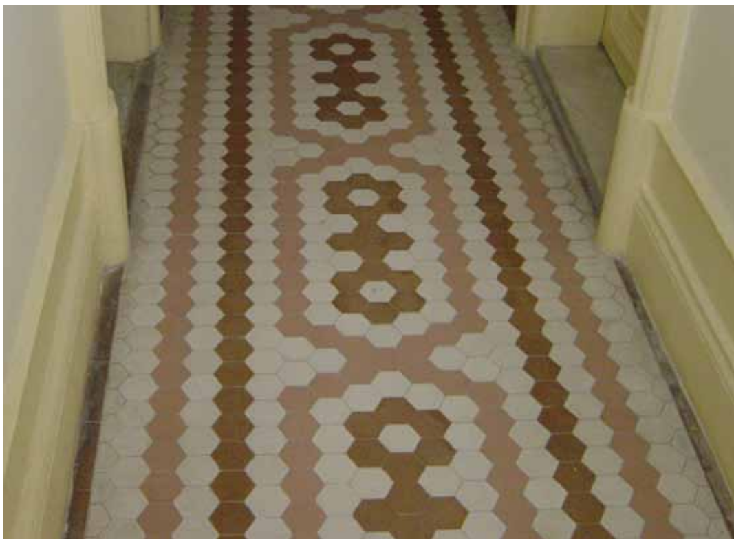
Foto 7 – Detalhe de piso em lajota hexagonal (circulação entre cômodos).
