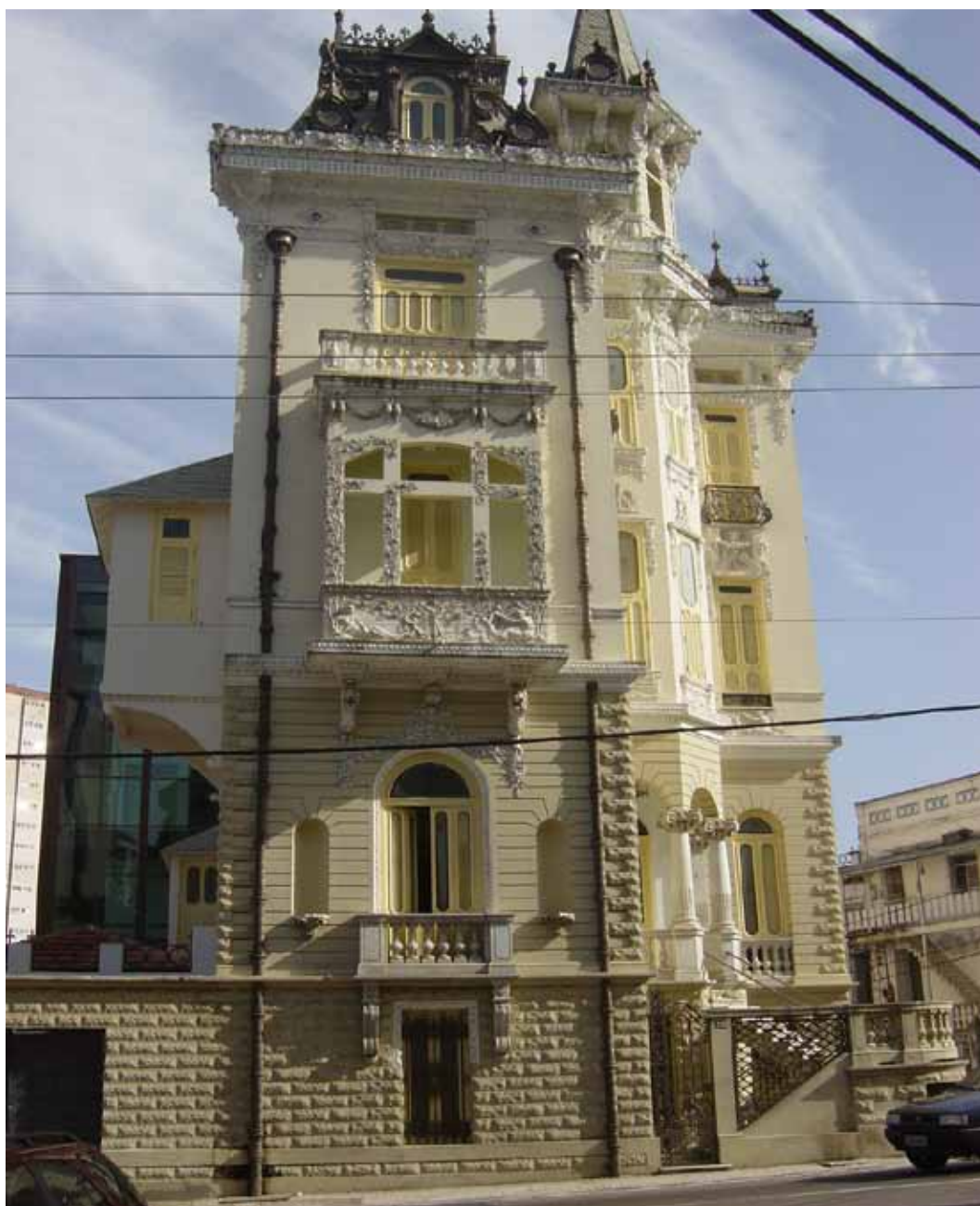
Foto 38 - Fachada frontal do Palacete Bolonha
