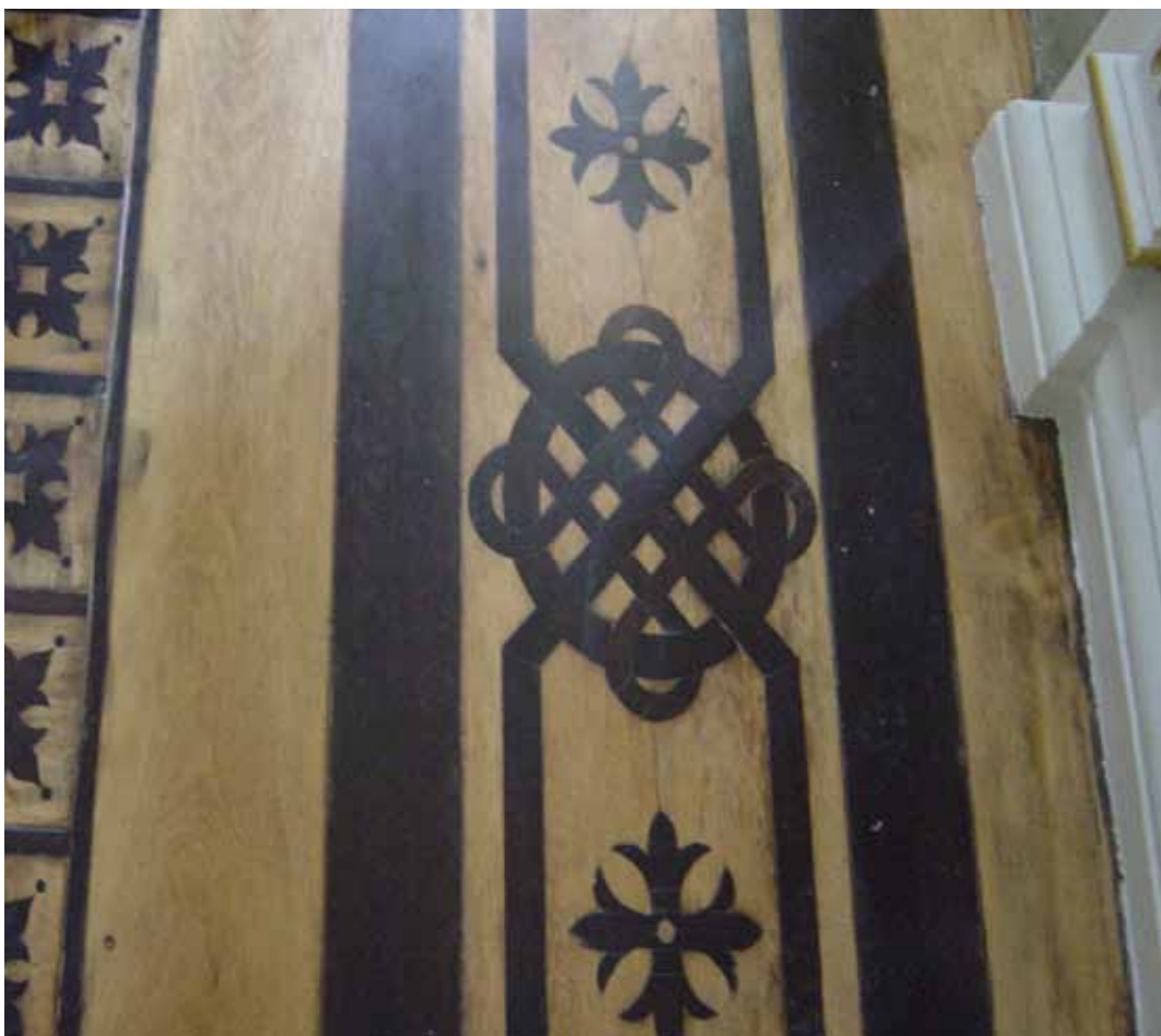
Foto 10 – Detalhe de piso em madeira: pau amarelo e acapú com incrustações.
