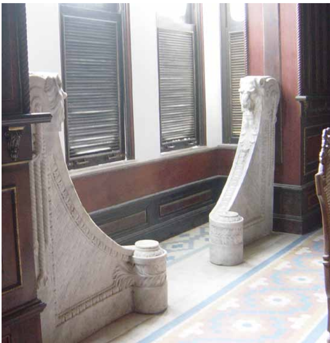
Foto 25 - Os arranques da escada social principal (leões) foram retirados do lugar original e colocados em local equivocado.
