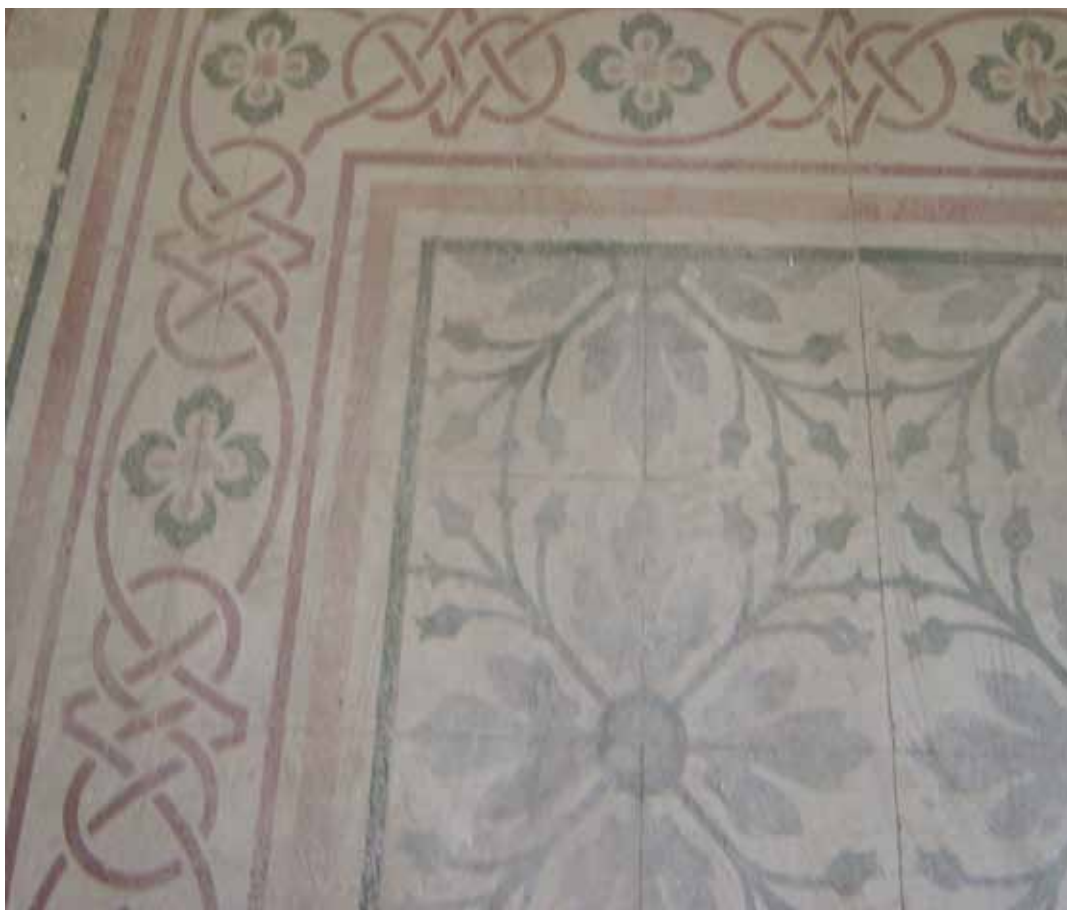
Foto 8 – Detalhe de piso em lajotas
