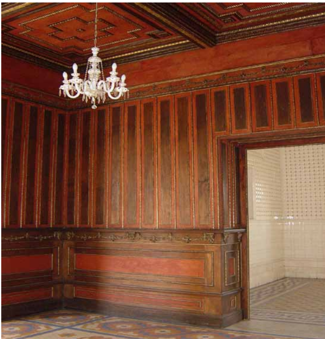
Foto 27 – SALA DE JANTAR – Paredes revestidas em madeira de lei, polida, e com aplicações em alto relevo, criando volumetria para o conjunto. As lajotas sextavadas do piso formam desenhos geométricos, que se multiplicam por toda a sala. Observar a direita, a sala de almoço da foto anterior que se comunica à sala de jantar, por uma larga porta que separa os dois ambientes. Esta sala somente era usada em ocasiões especiais, aniversários, natal, ano novo e recepções a políticos, artistas, empresários e visitantes por aqui de passagem. “Eu tinha 15 anos no dia do concerto. Via tudo de repente: a mesa de cristais finíssimos, toalhas bordadas, lindas!...” (Eneida Salamonde).
