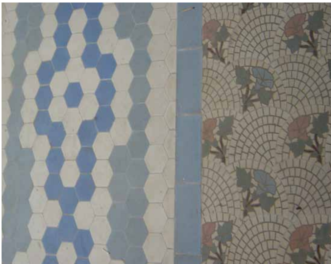
Foto 9 – Detalhe de pisos com combinação de lajotas hexagonais (esquerda) e lajotas em leque.
