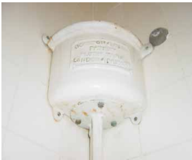
Foto 19 – Detalhe de descarga sanitária em metal importada da Inglaterra. Produzido por Doulton & Cº Limited Patent - London.
