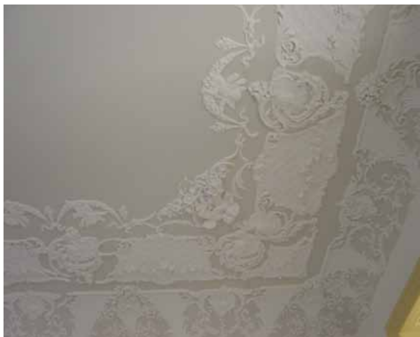
Foto 16 e 17 - Detalhes de forros em estuque.
