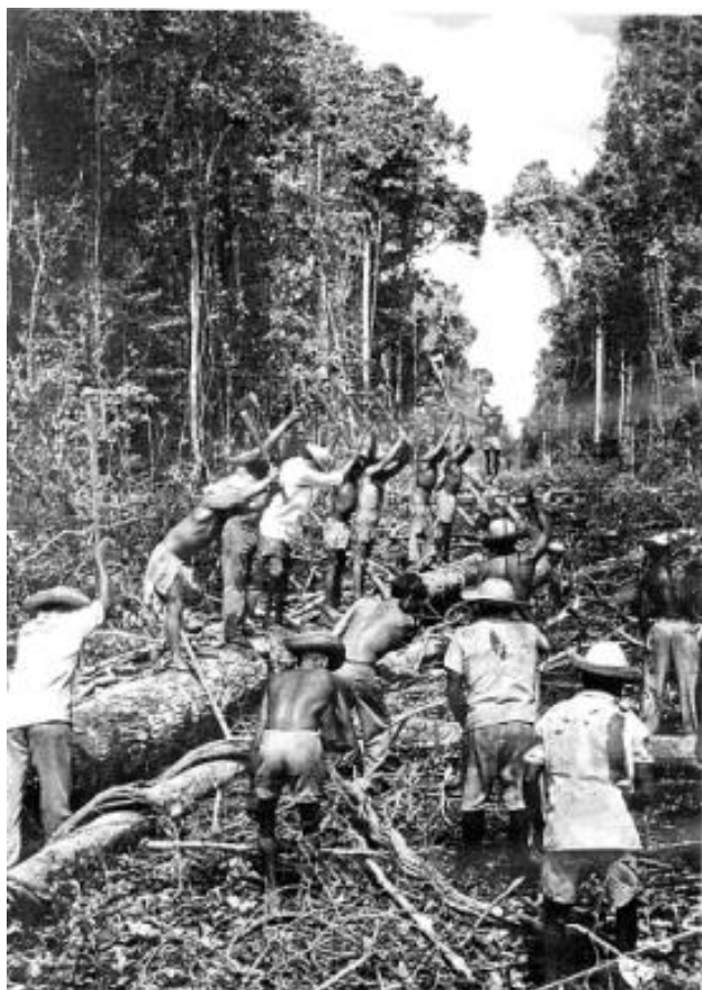
Foto: Agência Estado, fev. 1959.
