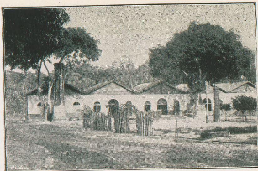
Utinga. Captação d'água. Casa das machinas.
