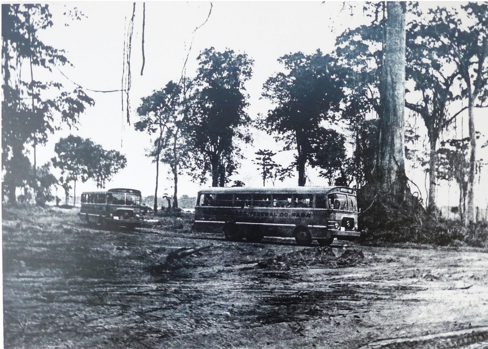
Construção do Campus Universitário do Guamá.
