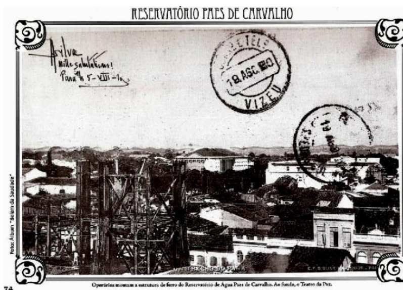
Figura 20 - Reservatório durante sua montagem
