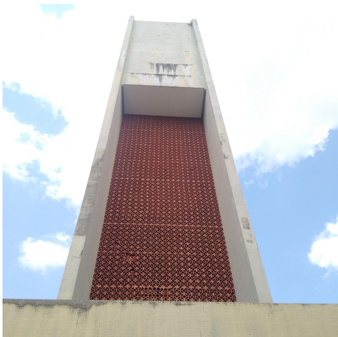
Figura 41 - Detalhe dos elementos da arquitetura moderna do reservatório atual
