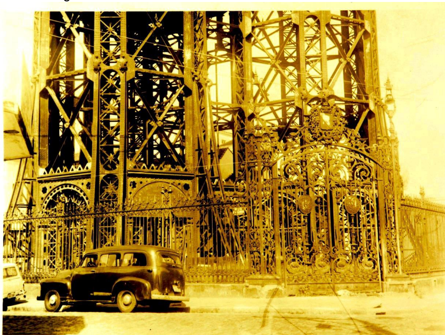
Figura 28 - Portão do Reservatório Paes de Carvalho
