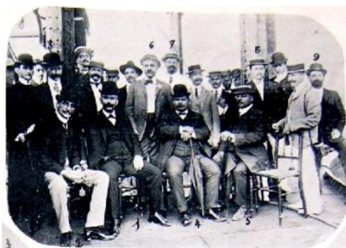
Figura 21 - Equipe responsável pela montagem reservatório
