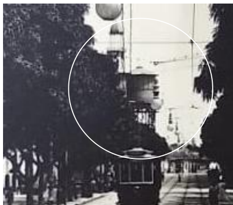
Figura 77 - Ampliação da imagem anterior da Avenida 15 de Agosto
