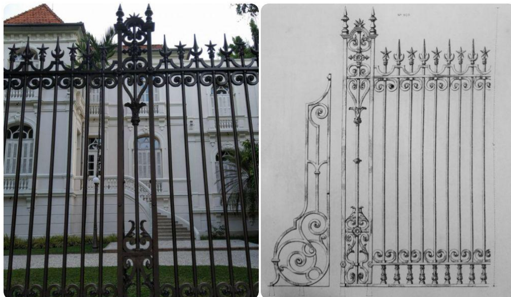
Figura 26 - Montagem de foto recente com o desenho do gradil nº 900 do catálogo
