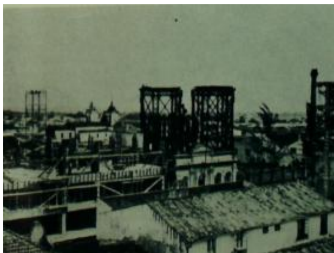
Figura 37 - Rara foto do desmonte do reservatório (1965) 44
