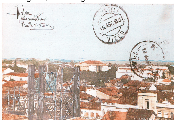
Figura 57 - Montagem do reservatório
