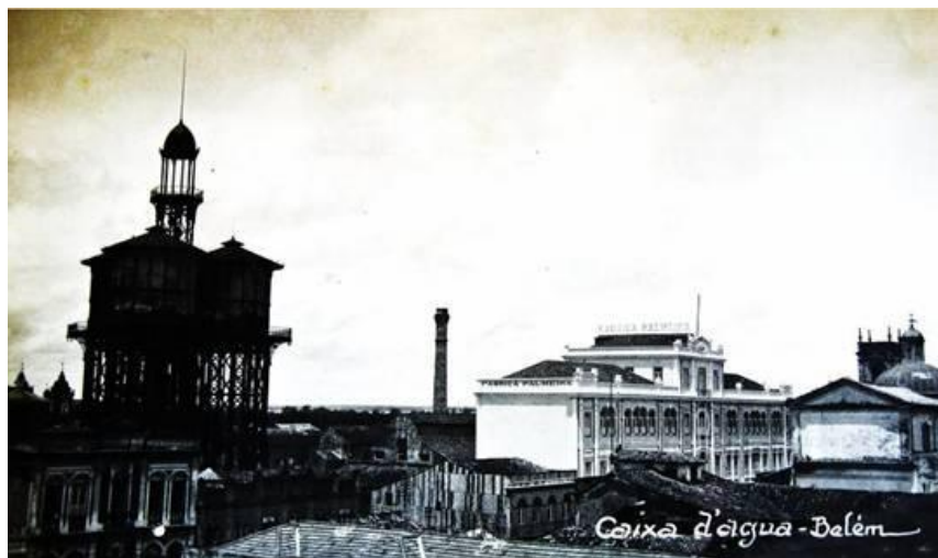
Figura 2 - Cartão Postal Fábrica Palmeira e Caixa D'Água
