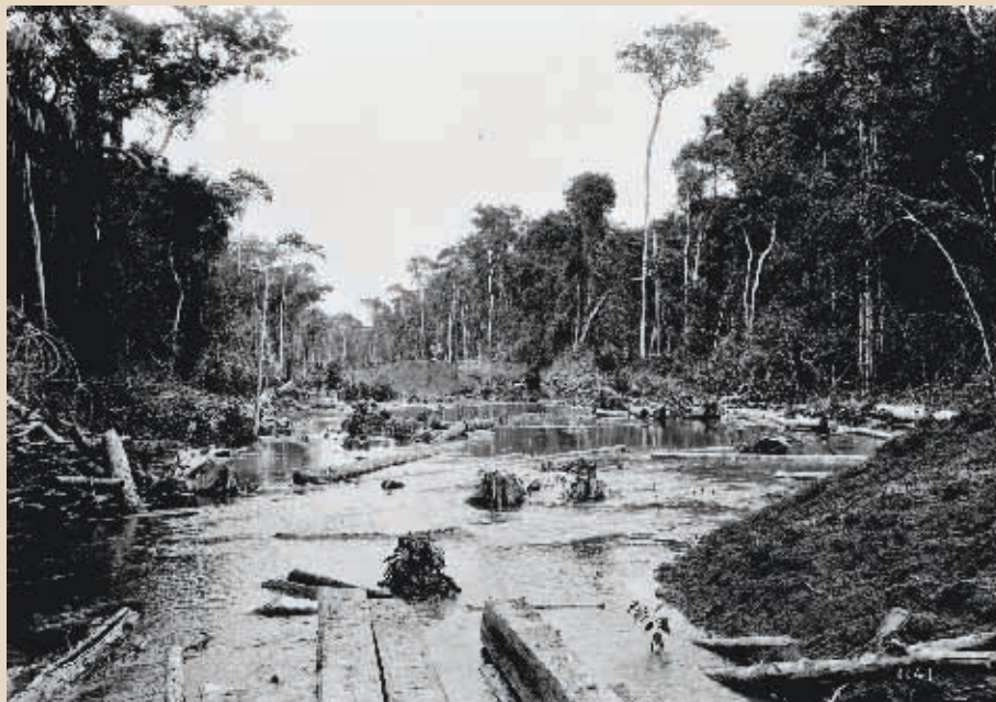
Inundação de área já aberta na mata para construção da ferrovia, em período de cheia do rio Madeira.
