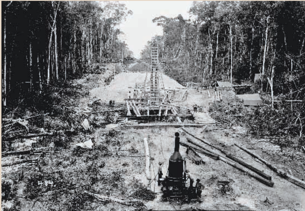
Trecho em construção da ferrovia em área de mata densa. Em primeiro plano, uma betoneira a vapor. Do acervo do MP/USP.
