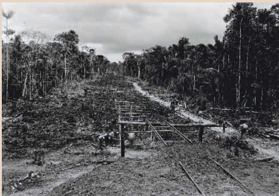
Abertura e construção da Estrada de Ferro Madeira-Mamoré. Preparação da estrutura elevada.
