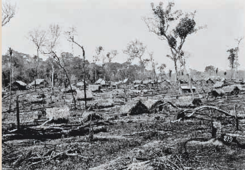
Acampamento de operários da ferrovia construído em área devastada da floresta. Do acervo do MP/USP.
