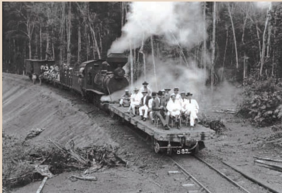
Autoridades em visita à Madeira-Mamoré. Assim pode ter sido quando Oswaldo Cruz percorreu 113 km da via férrea em construção 50 .
