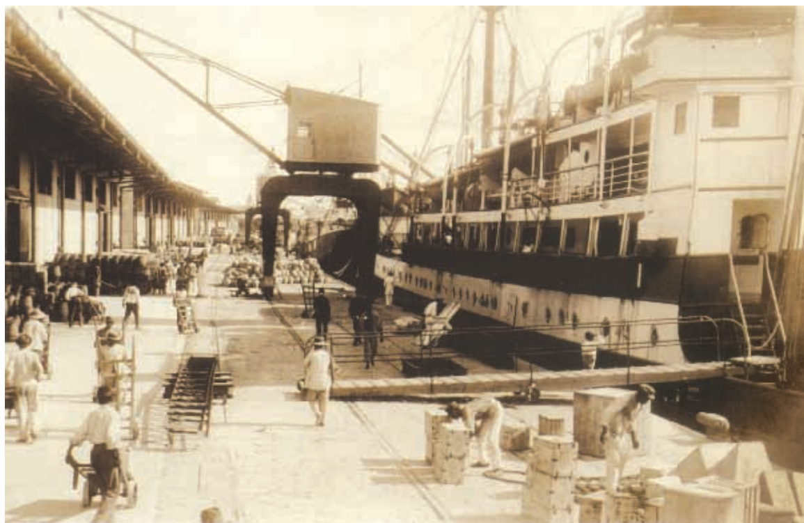
Fotografia das modernas docas do Porto de Belém à época da campanha, dotadas de extenso cais acostável, armazéns e guindastes. Aí desembarcaram os homens da Comissão. Reproduzida de Gerodetti e Cornejo (2006, p. 30).
