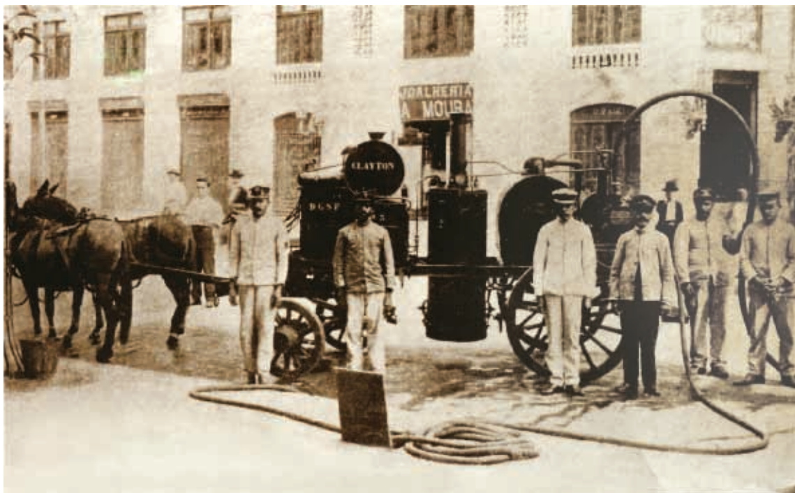
Aparelho Clayton destinado ao expurgo de galerias de águas pluviais por insuflação de gás sulfuroso. Fotografia feita no Rio de Janeiro, quando da vitoriosa campanha antiamarilica que antecedeu à de Belém.
