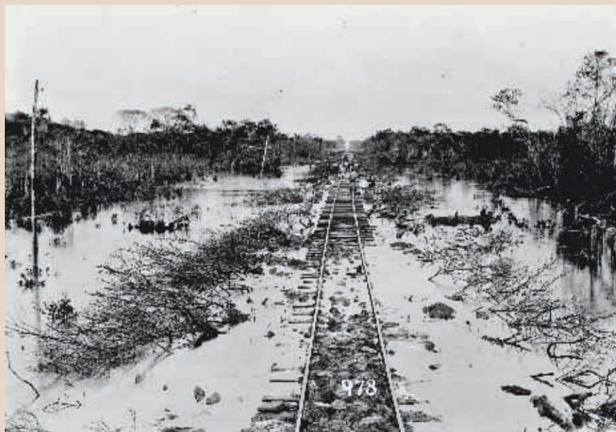
Enchente do Abunã inundando trecho já construído da ferrovia.
