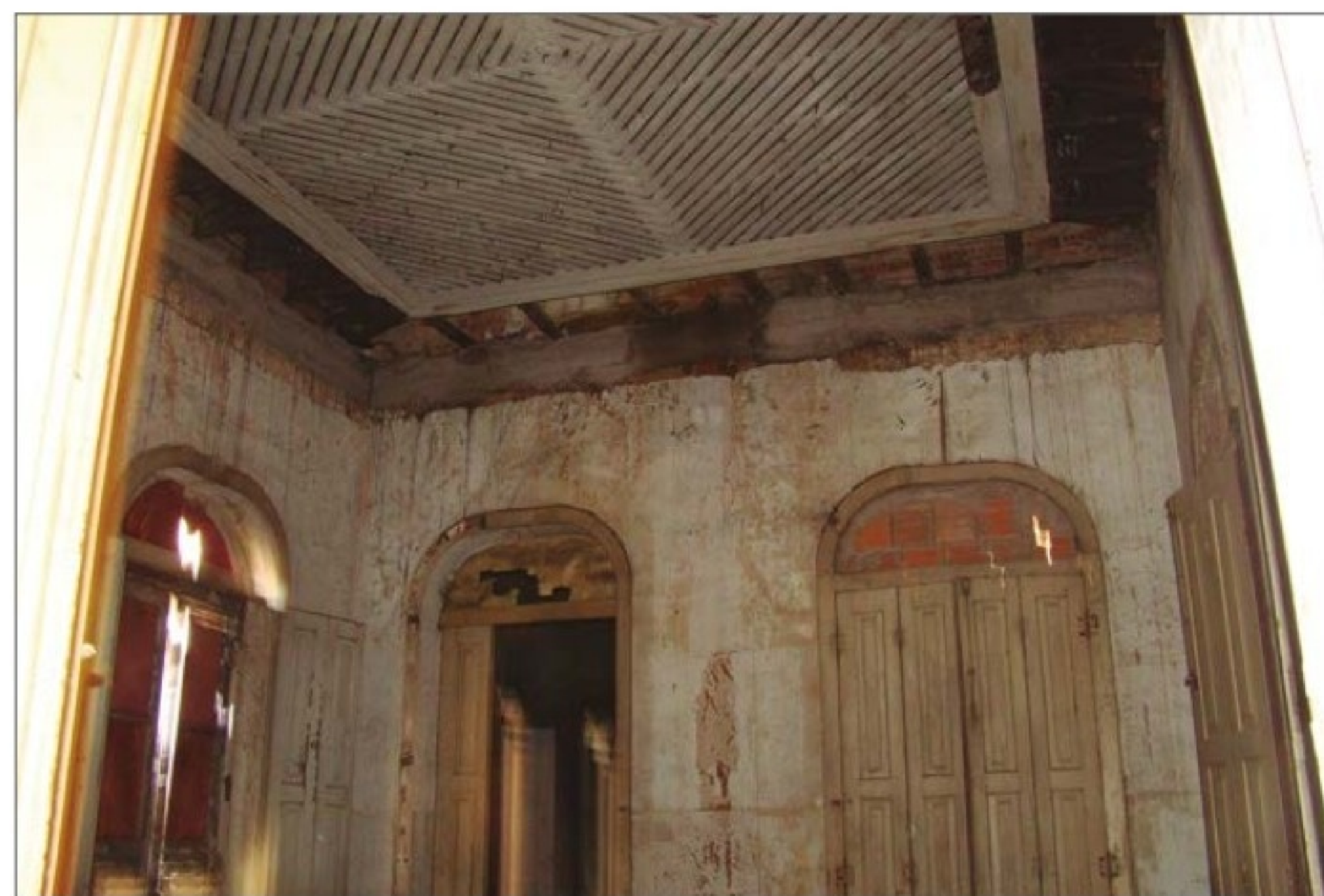
Ambiente do anexo do pavimento térreo, em 2016, que abriga, atualmente, o acervo da biblioteca. (KM)
