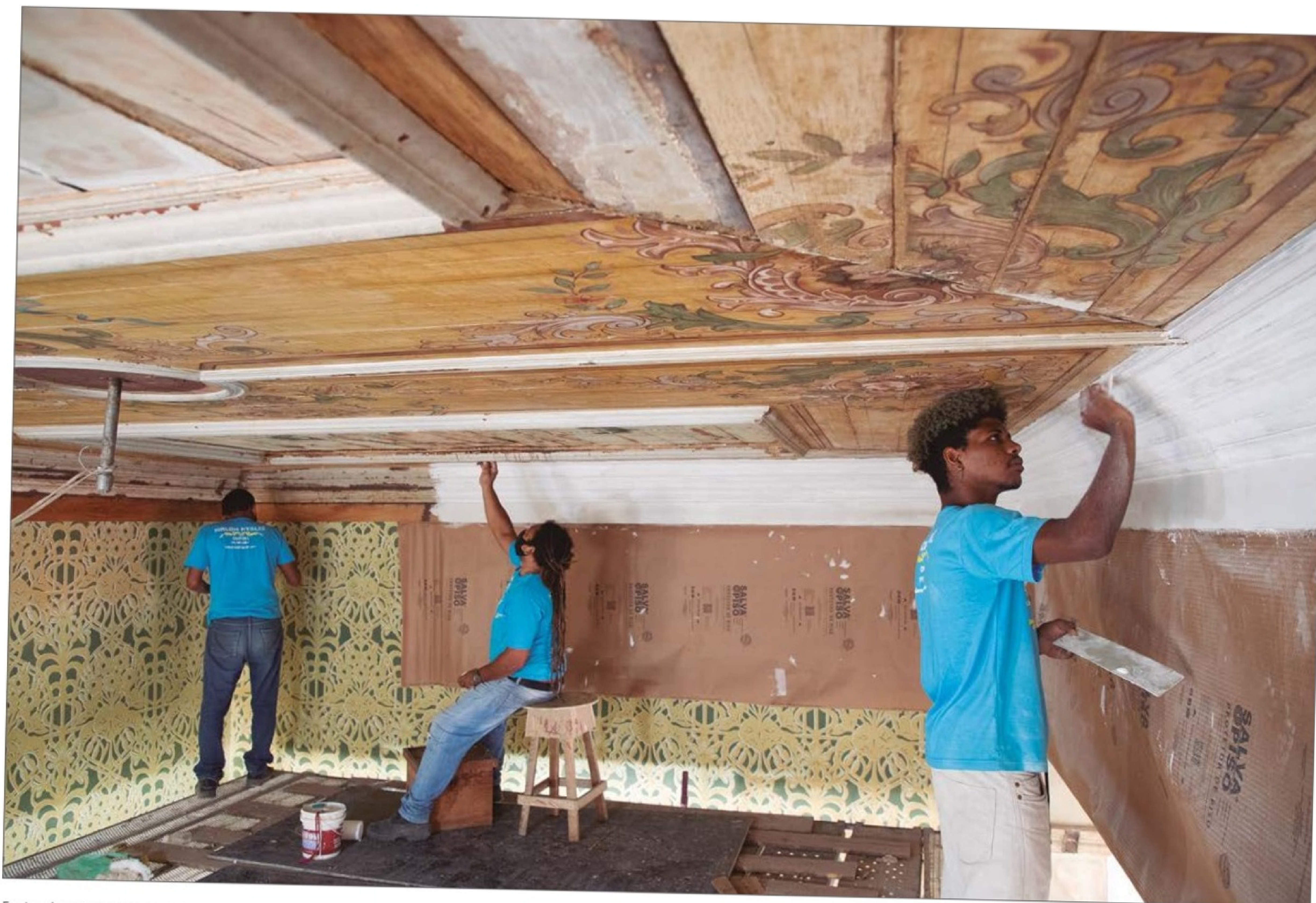
Equipe de restauradores trabalhando no forro do Salão Principal. (OC)
