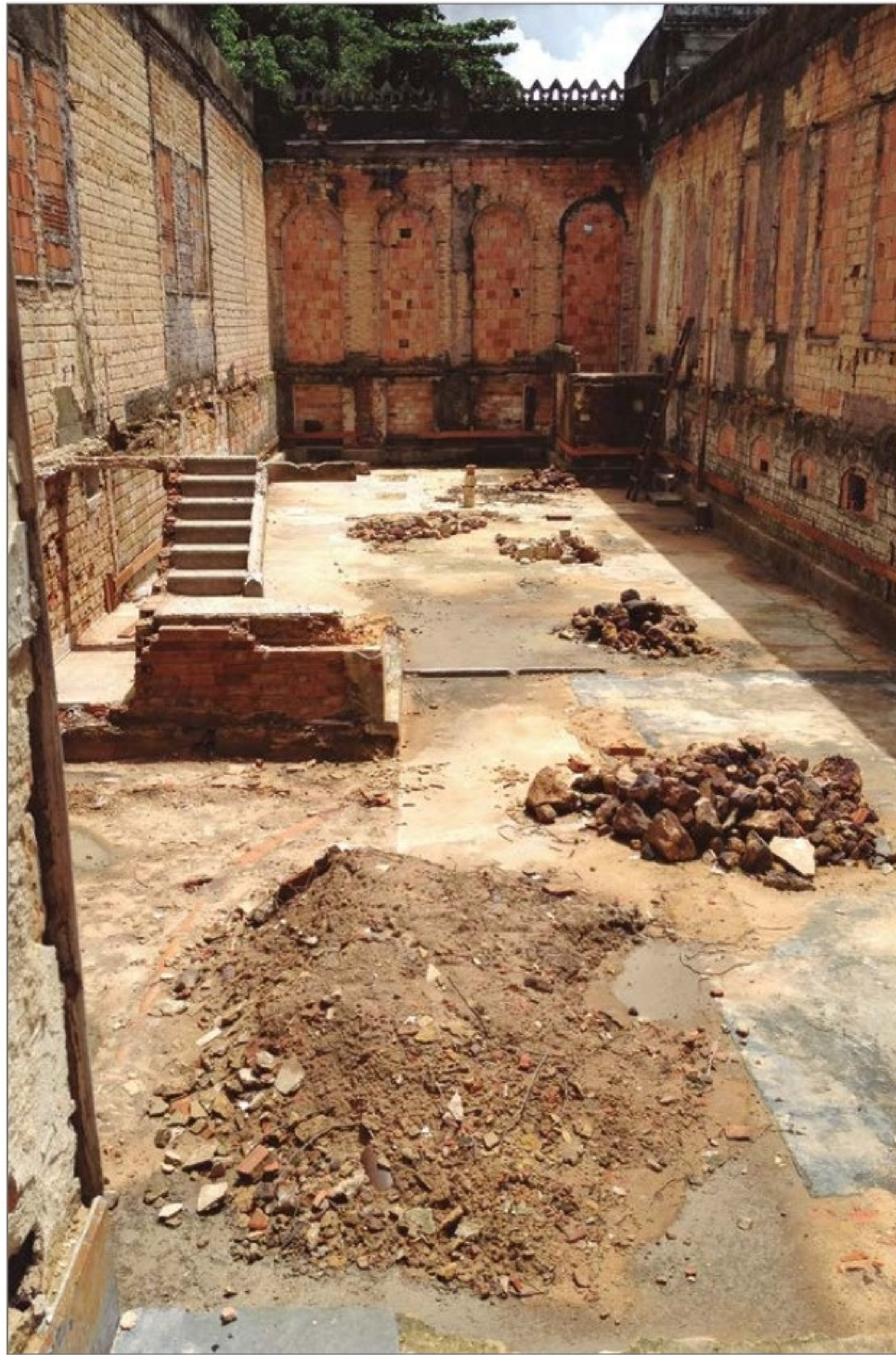
Casa 03, em 2016, quando foi limpa. (KM)
