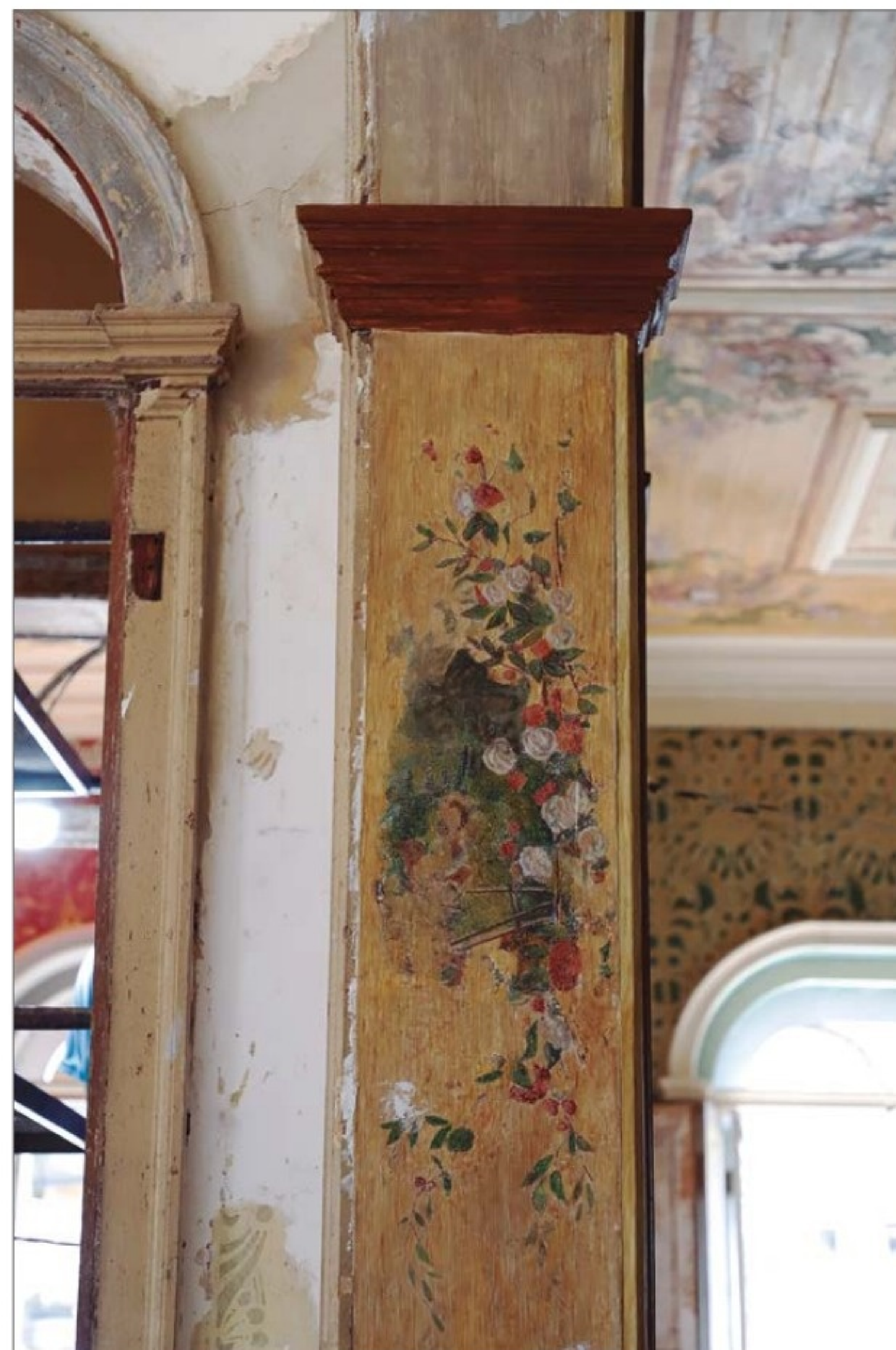
Artes encontradas, como nas laterais dos arcos, tratadas e expostas. (OC)
