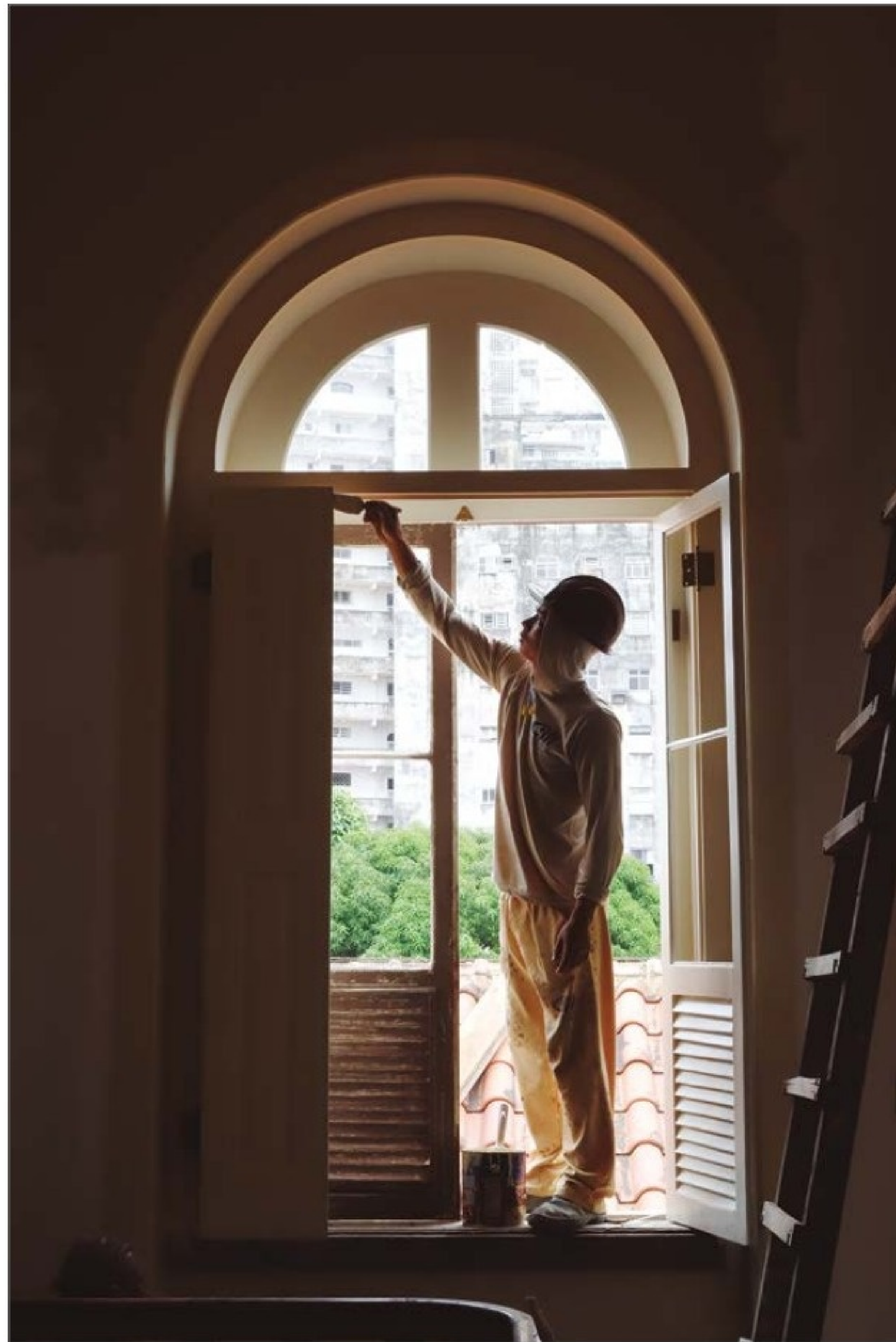
Acabamento na pintura das janelas. (OC)
