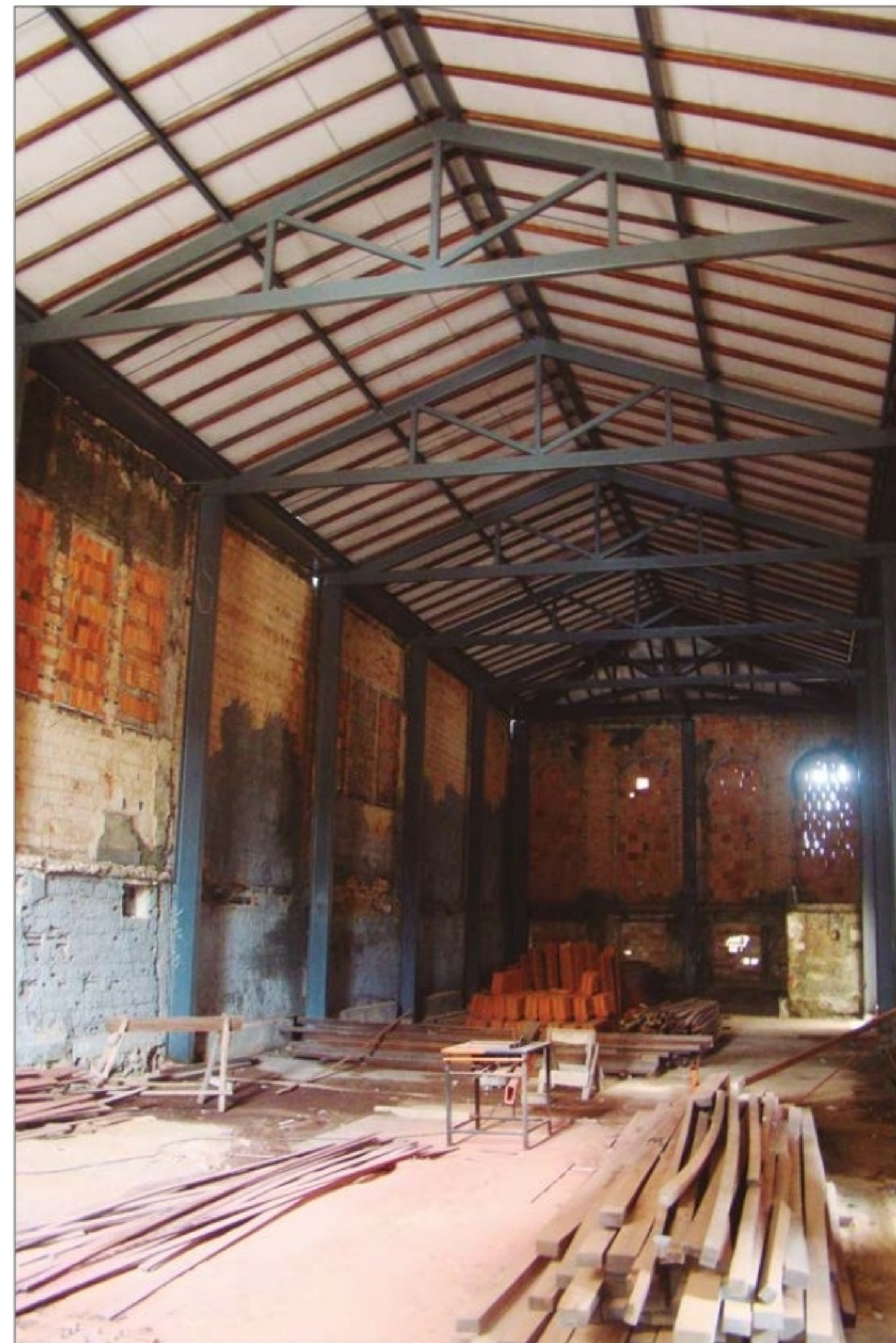
Casa 03, em dezembro de 2016, quando a obra de reforço estrutural realizada instalou um novo sistema de cobertura e de sustentação das paredes. (KM)
