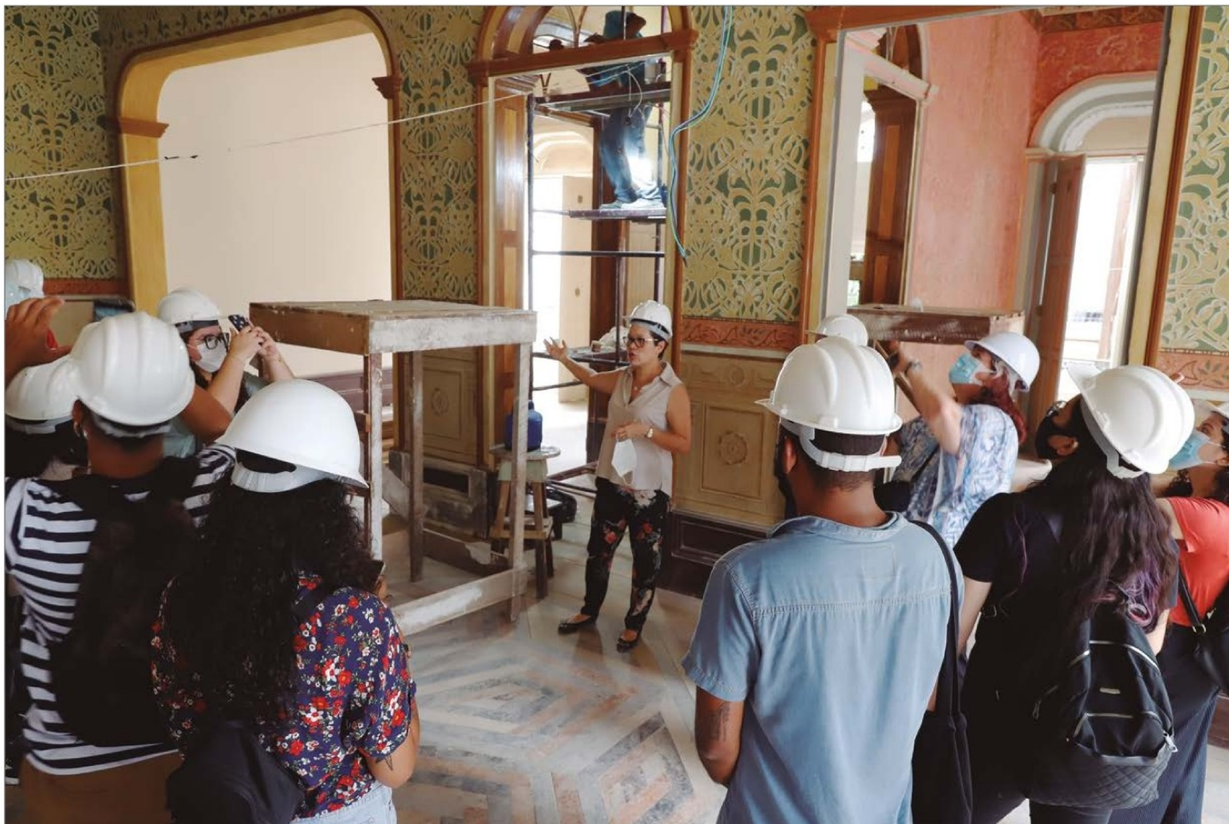
Visita de estudantes universitários dos cursos de Arquitetura e Urbanismo e demais interessados realizada durante a obra, promovendo a educação patrimonial. (OC)
