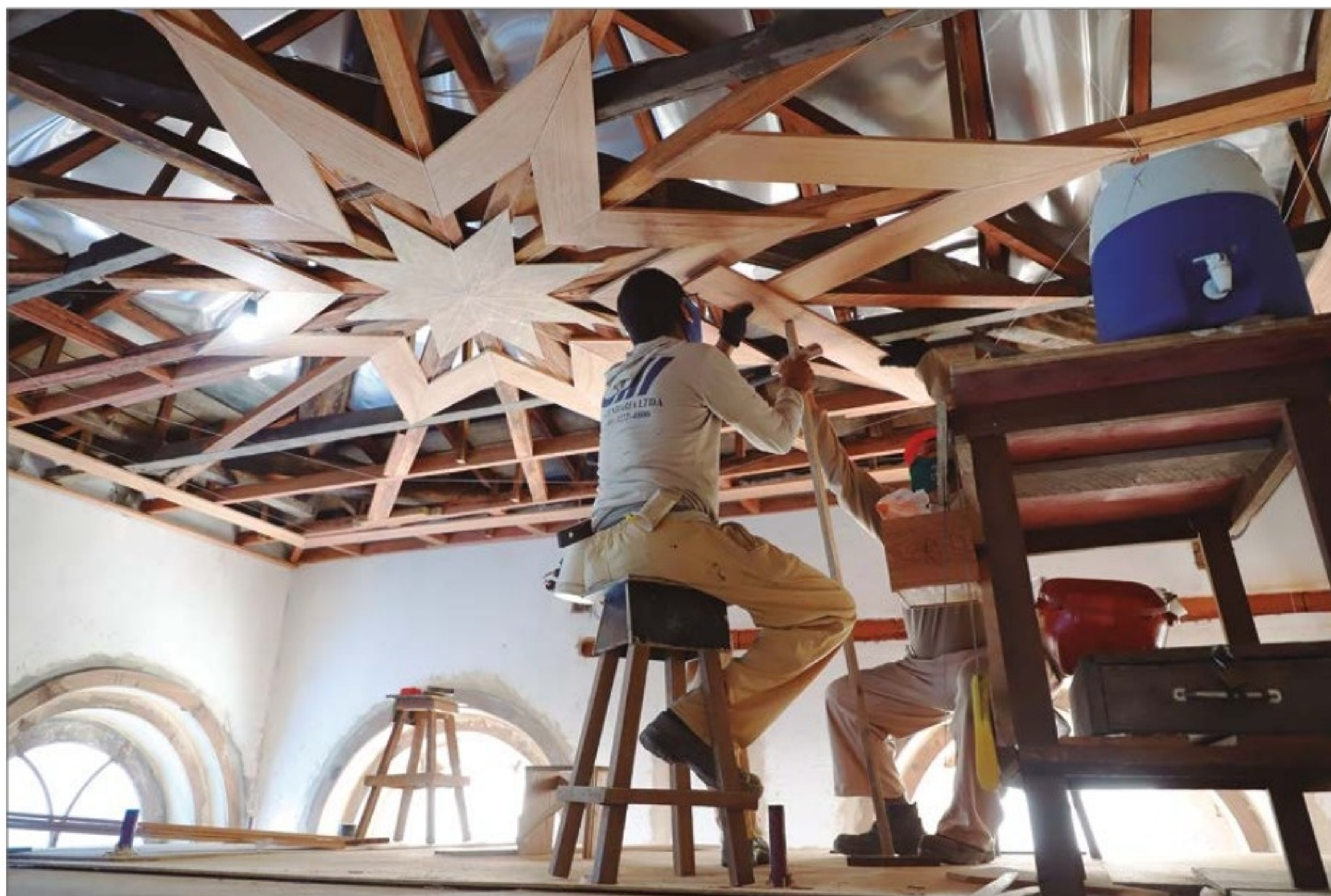
Forros refeitos segundo o seu desenho original, utilizando-se madeira de lei. (OC)
