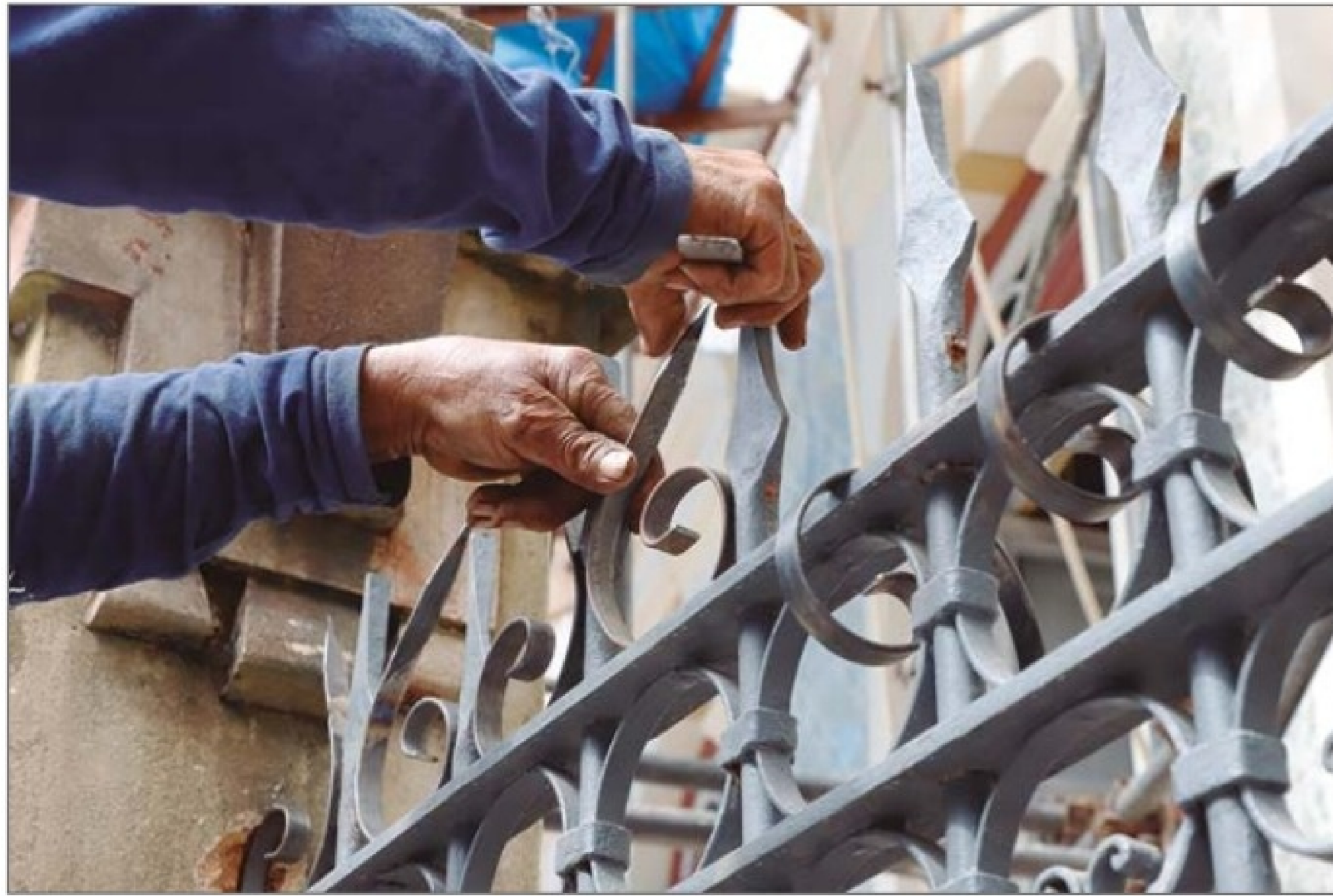
Gradil de ferro do muro restaurado. (OC)
