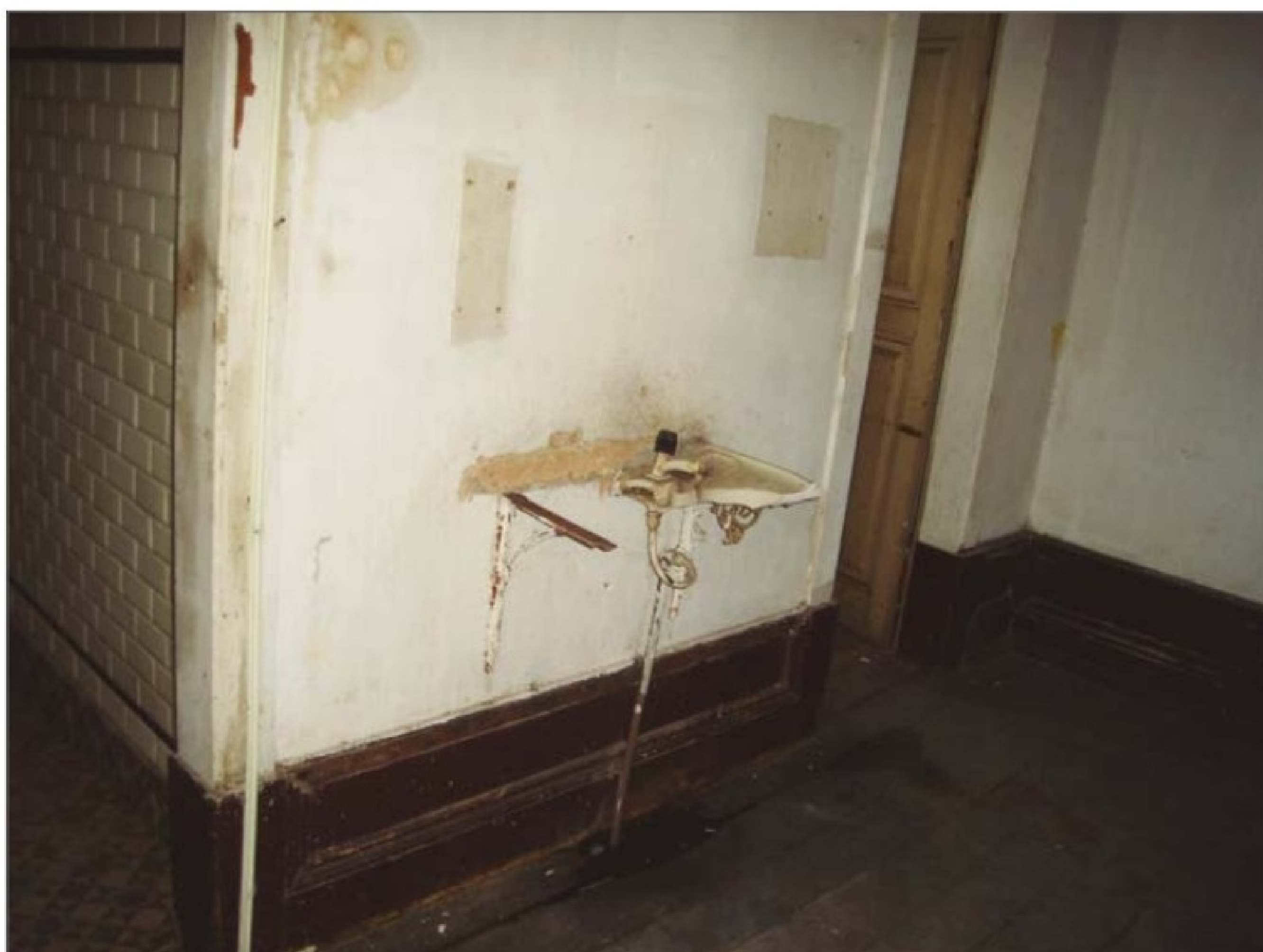
Banheiros no corredor do pavimento térreo, onde havia uma pia em louça de época. (AS)
