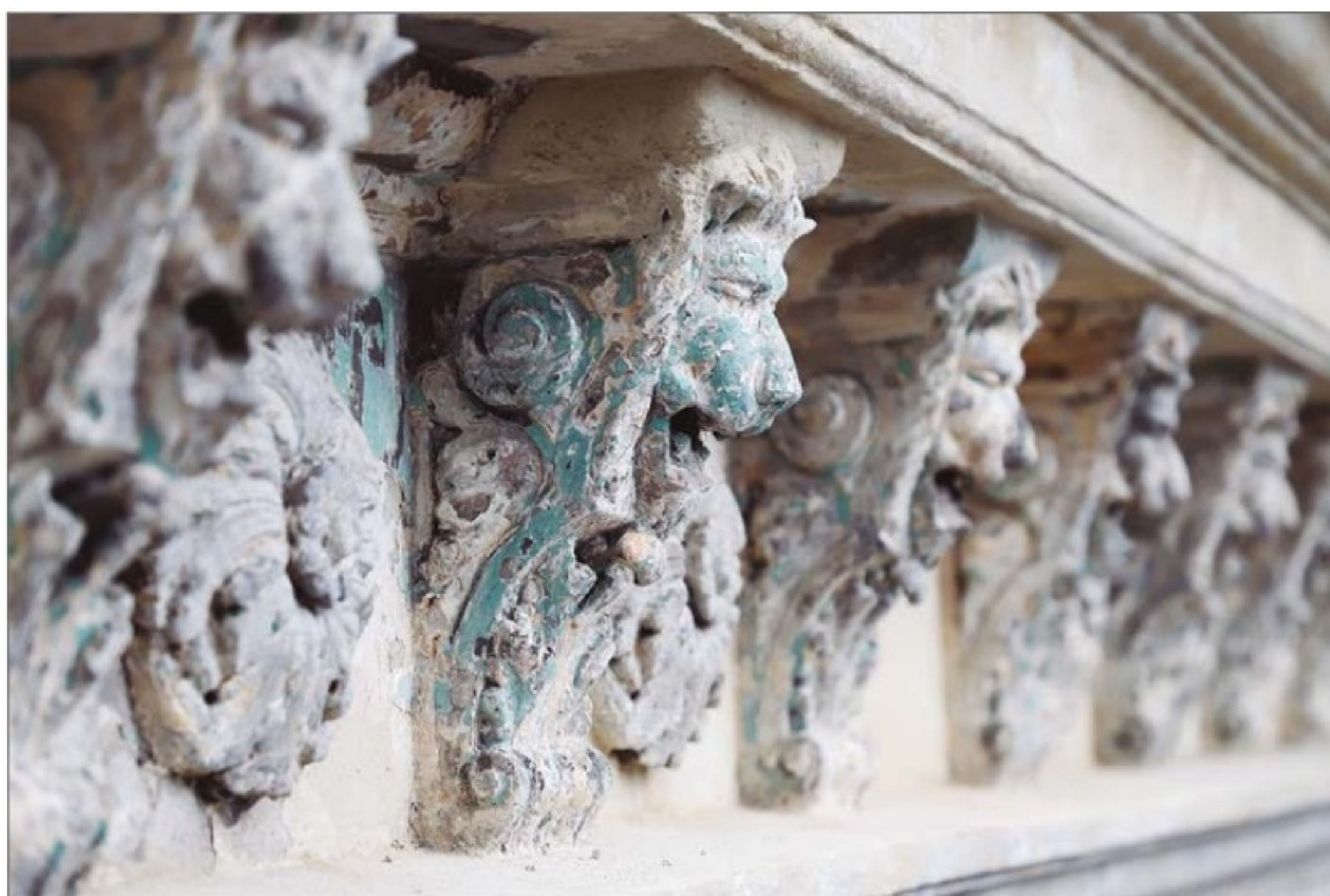
Elementos artísticos das fachadas, mais visíveis após a limpeza. (OC)
