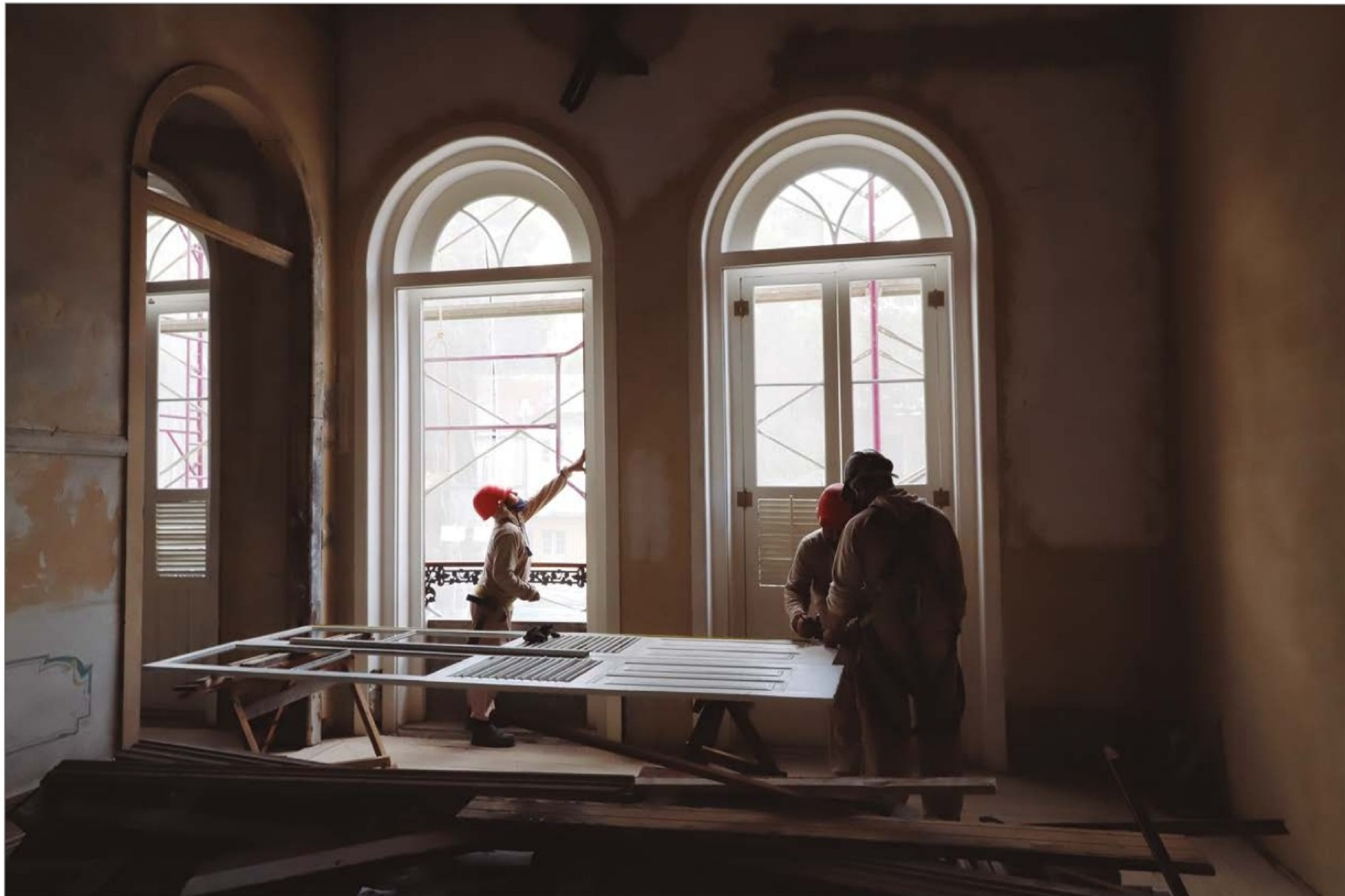
Reposição das esquadrias externas no pavimento superior. (OC)
