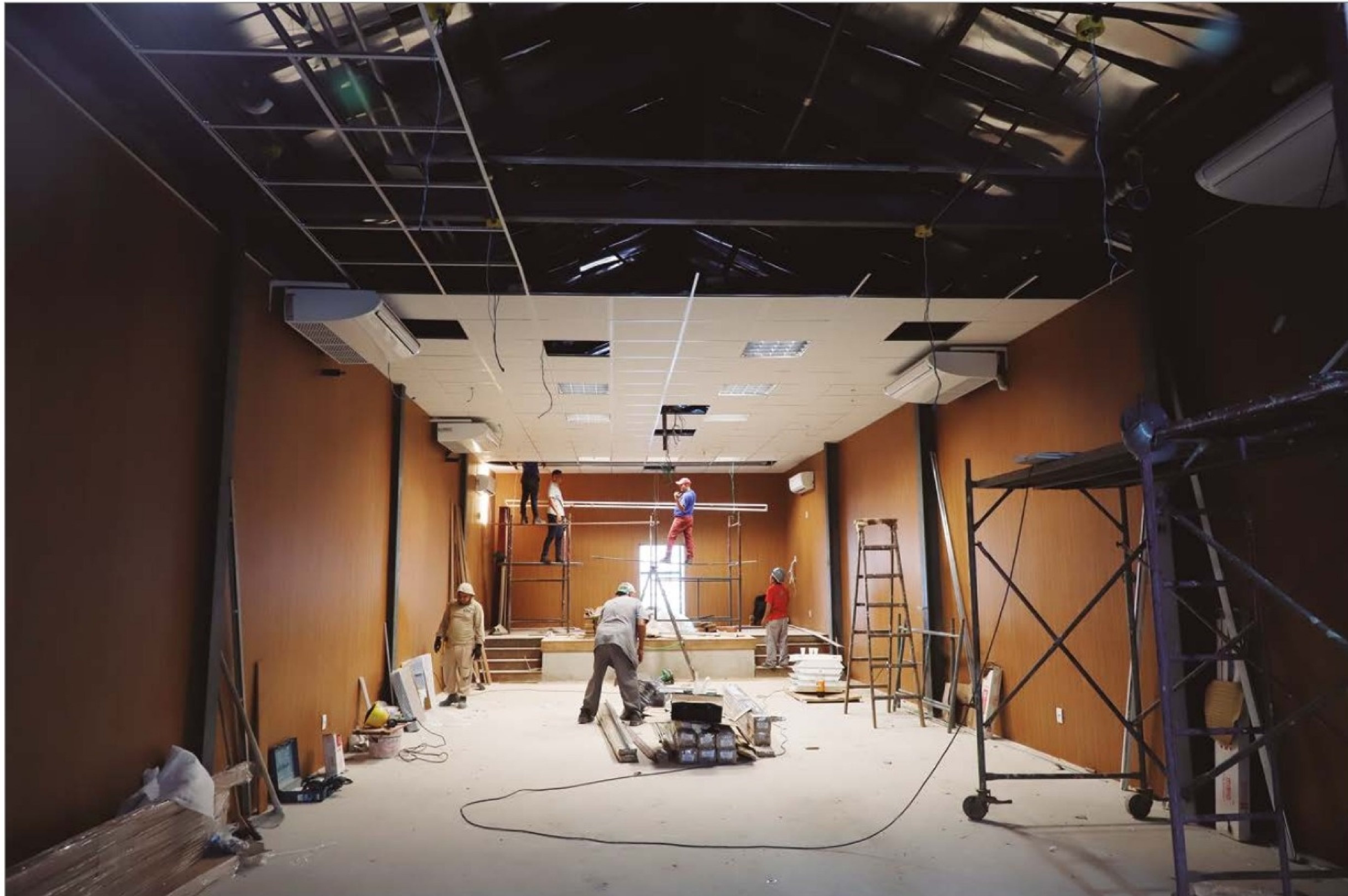
Auditório da Casa 02 recebendo acabamentos com características termoacústicas. (0C)
