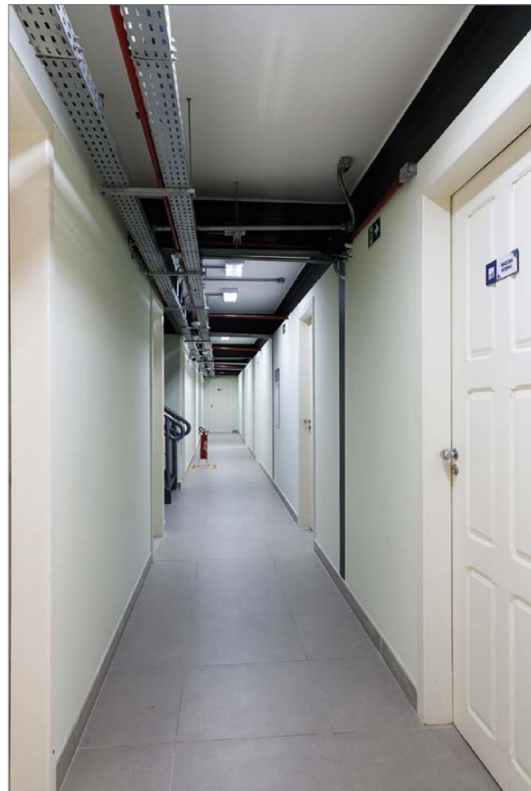
O porão da Casa 03 sofreu alterações – com o aumento do pé-direito e a inclusão de novas estruturas – para assegurar o funcionamento do setor administrativo do MIS. (OC)
