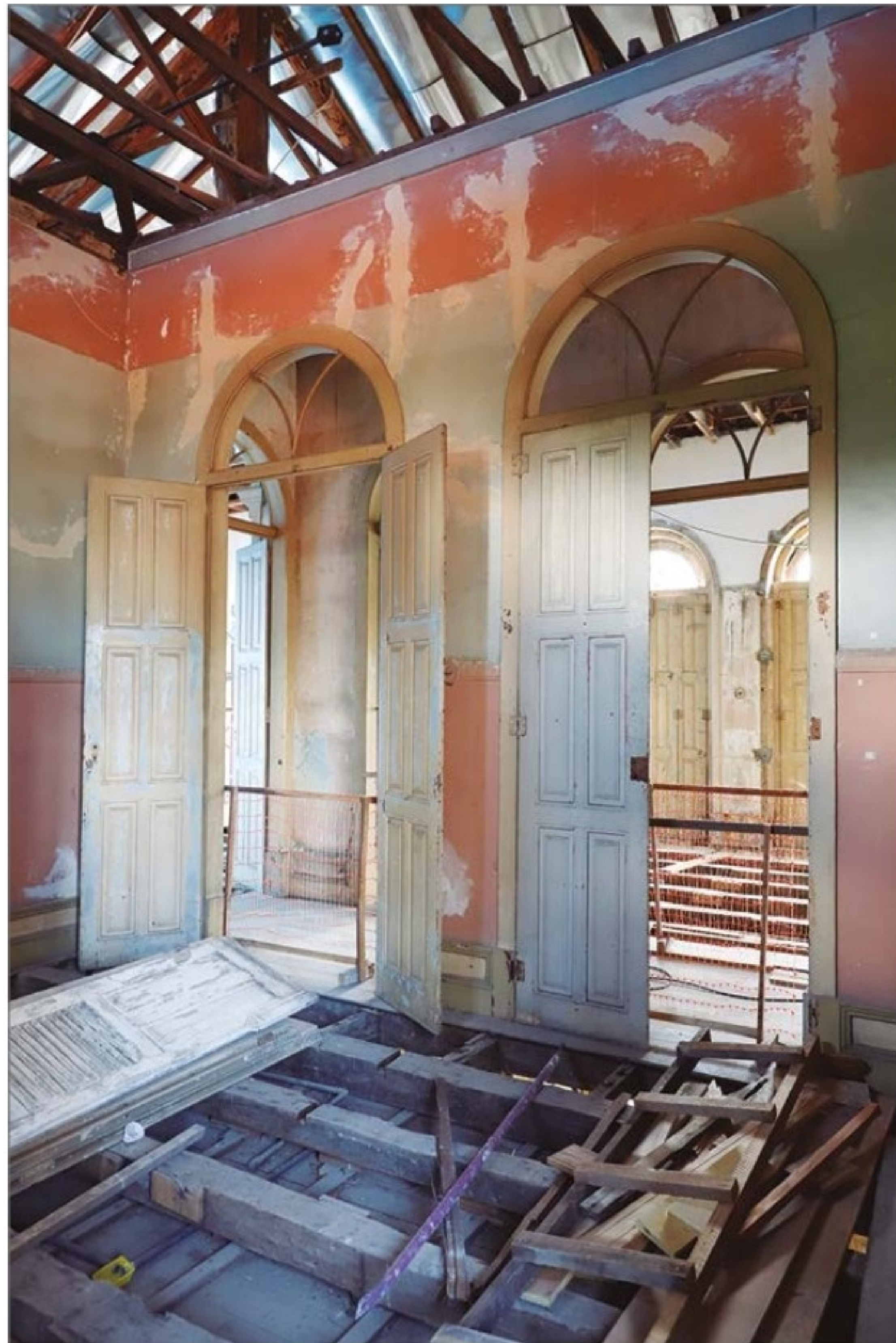
No pavimento superior, tanto o forro quanto o piso tiveram a sua estrutura mantida, porém a maior parte das peças de acabamento foi refeita. (OC)
