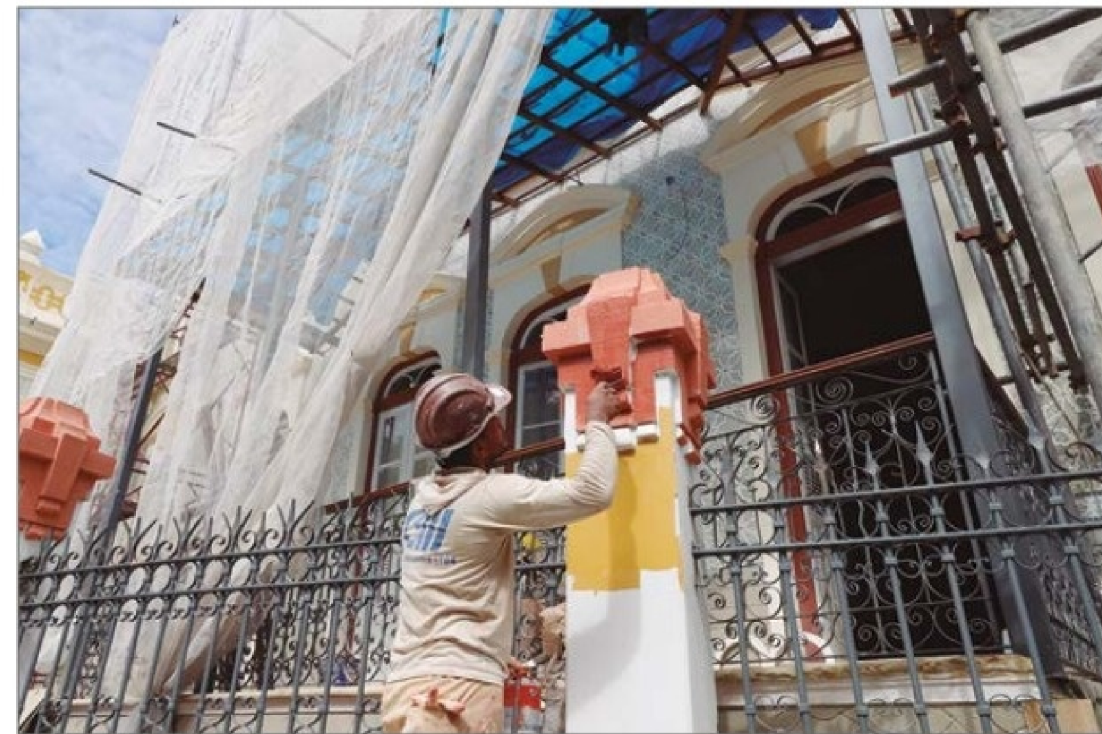
Uso de tintas e cores apropriadas no muro da travessa Doutor Moraes. (OC)
