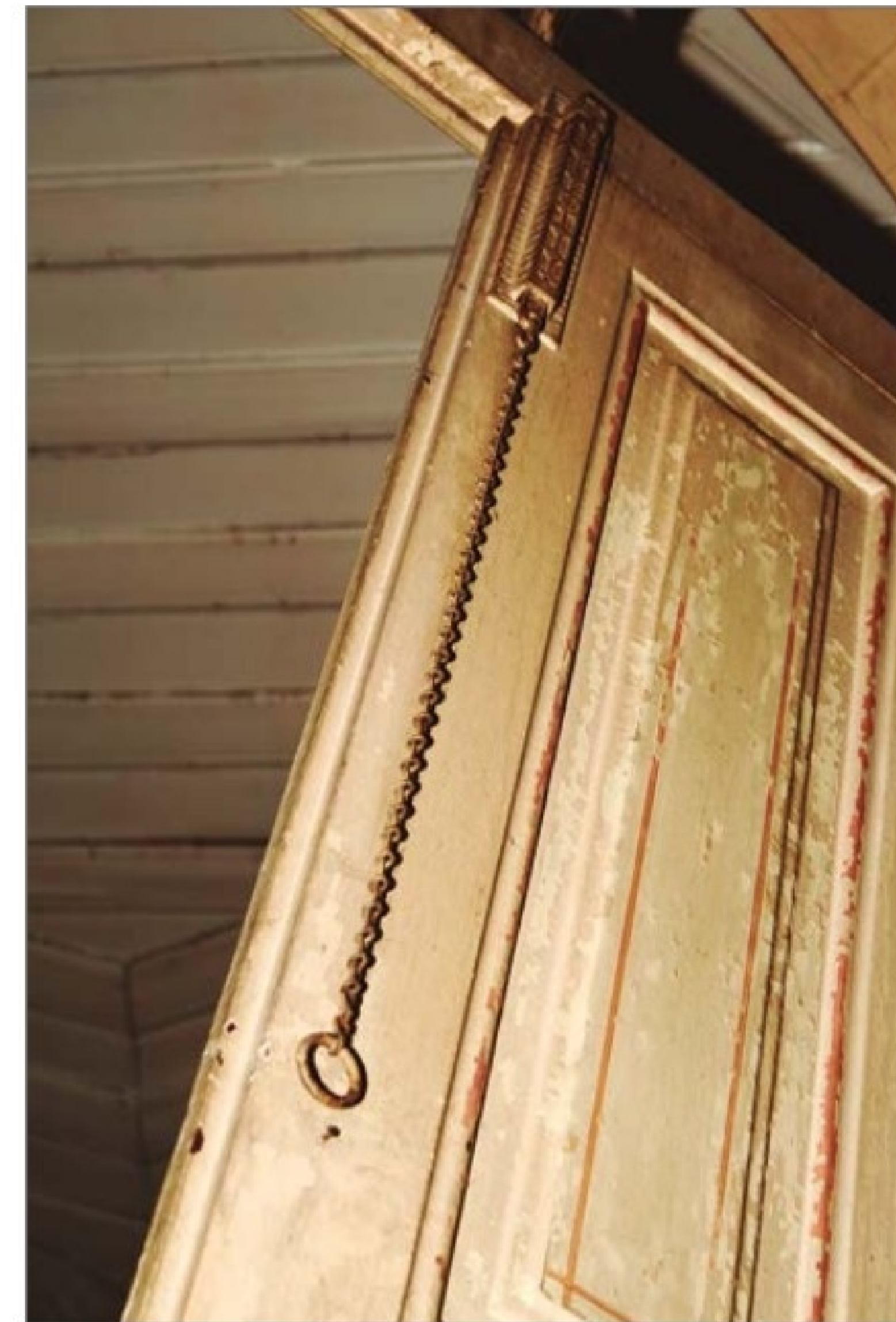
Detalhe das portas internas com trincos em ferro e pinturas diferenciadas nas peças de madeira. (AS)
