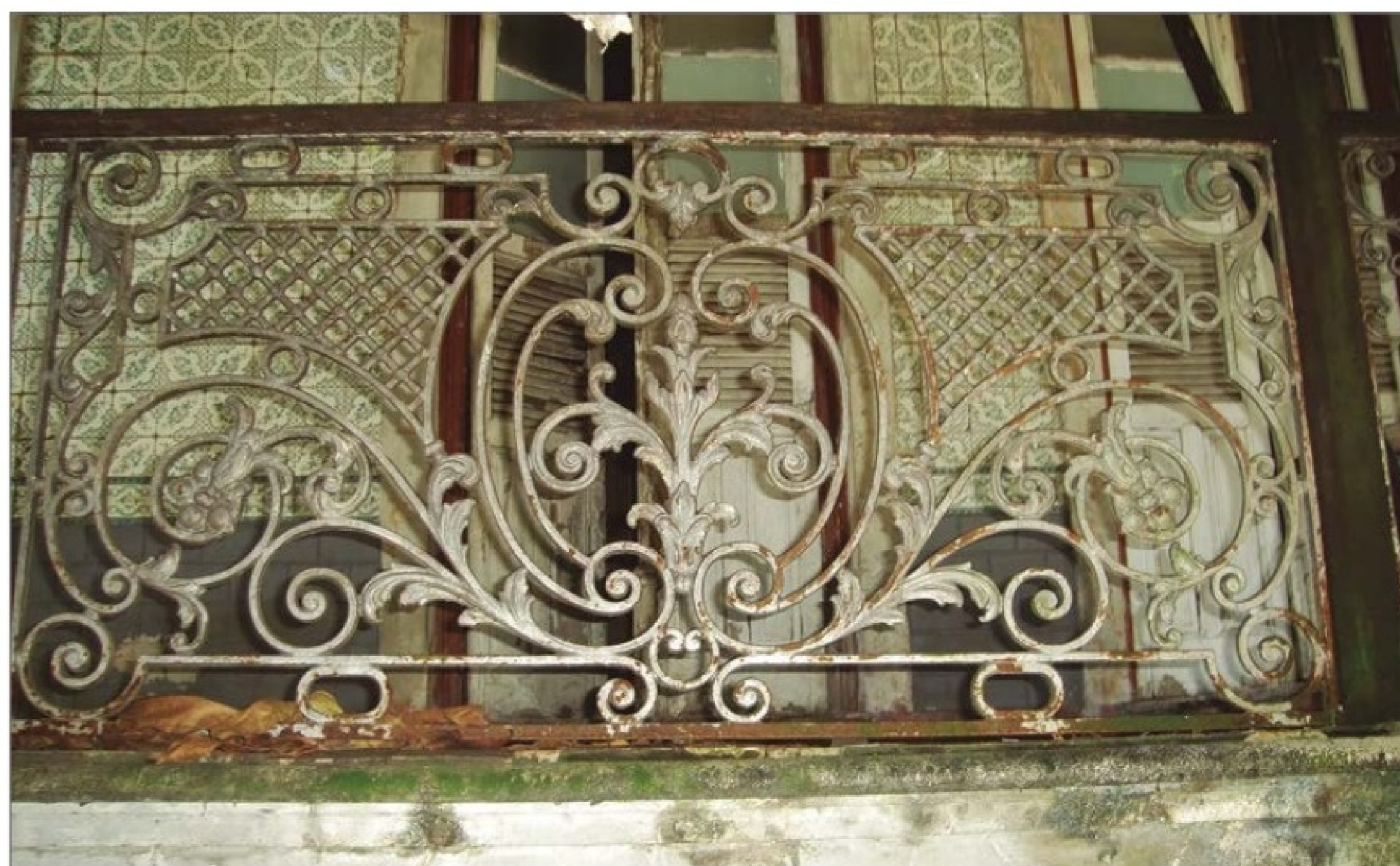
Gradil em ferro fundido que existia na edificação, 2007. (AS)
