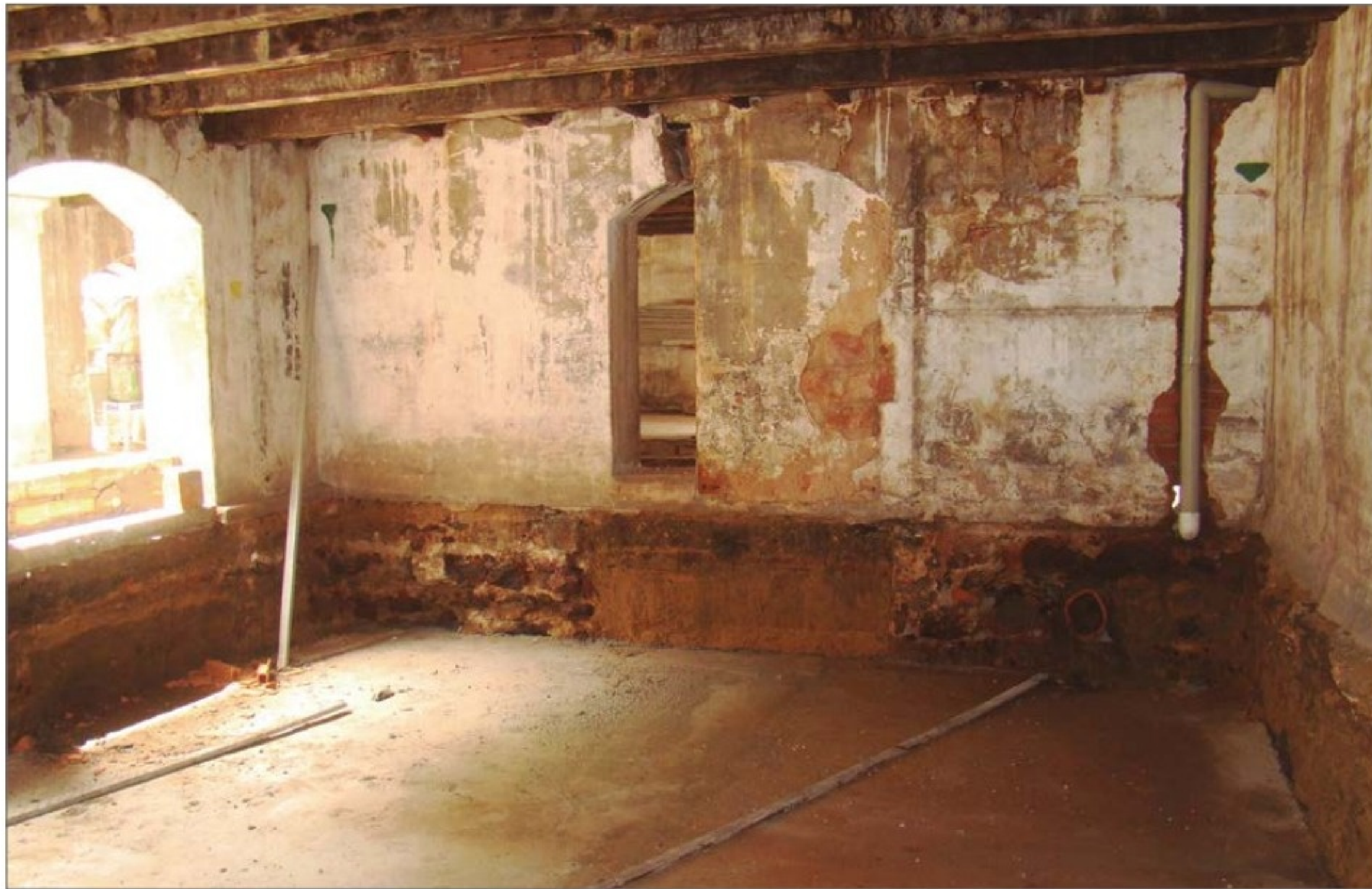
Parte do porão do Palacete, escavado, em 2016, para se obter um pé-direito suficiente para o seu uso. (KM)
