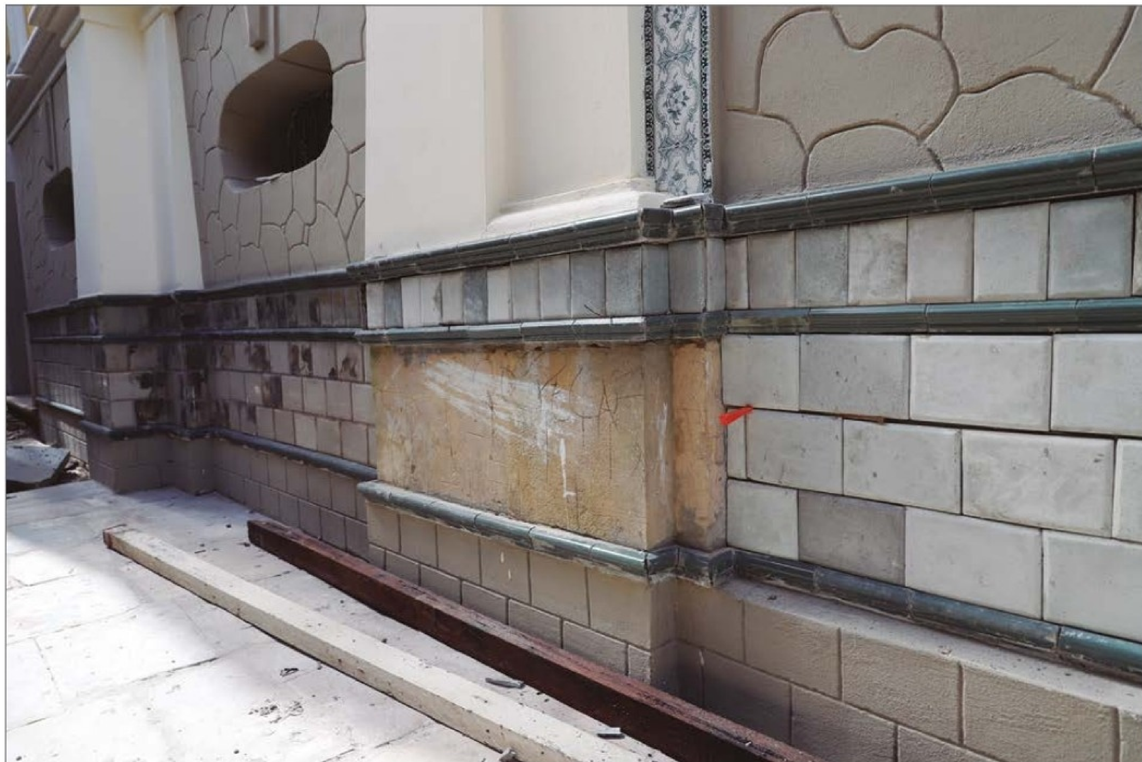
Nas fachadas, as peças de azulejos mais danificadas foram substituídas por réplicas, mas algumas peças antigas foram mantidas para demonstrar a ação do tempo. (OC)
