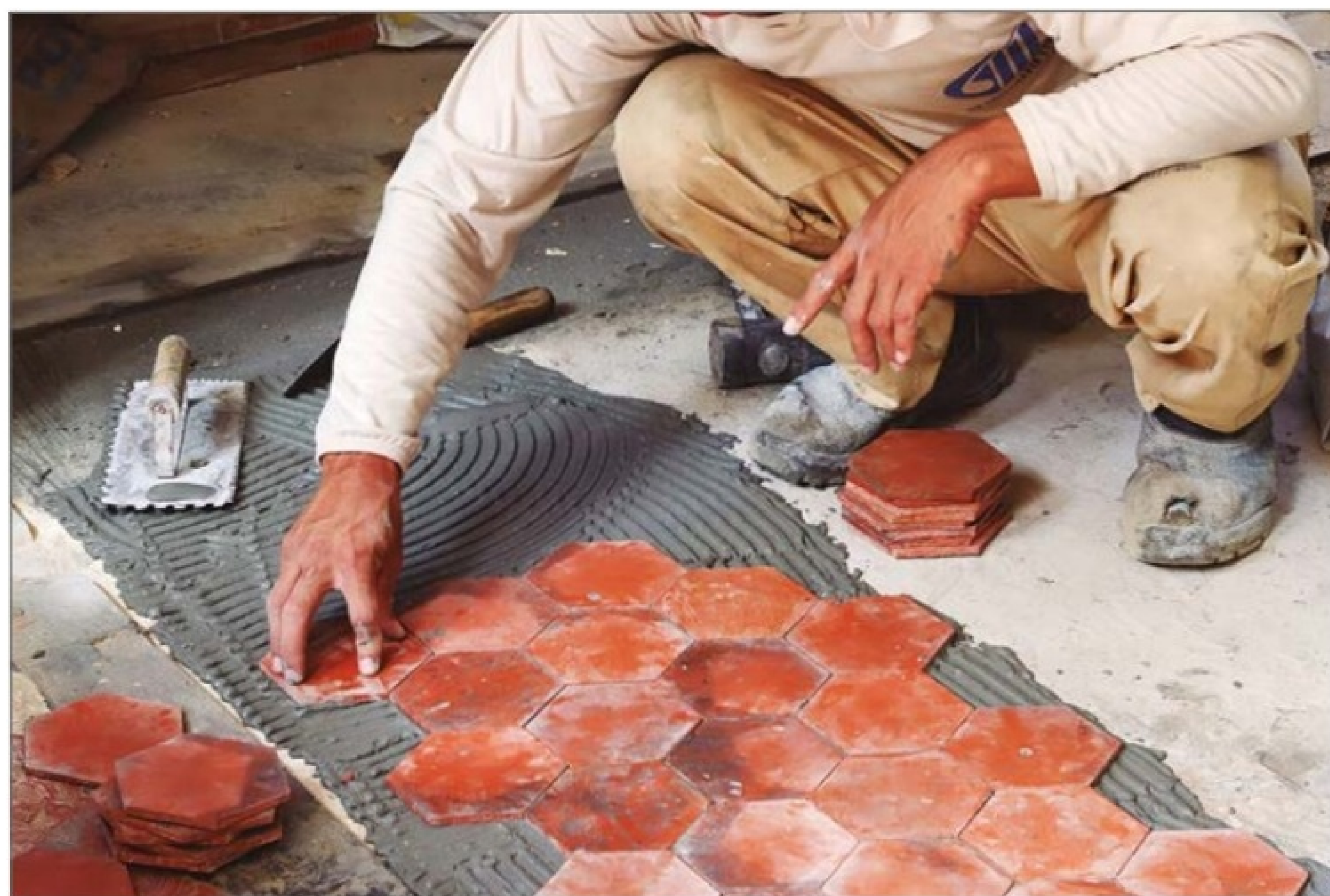
Piso cerâmico do tipo São Caetano restaurado no corredor e na copa. Nos antigos quartos, foram instaladas peças novas, similares ao piso de época. (OC)
