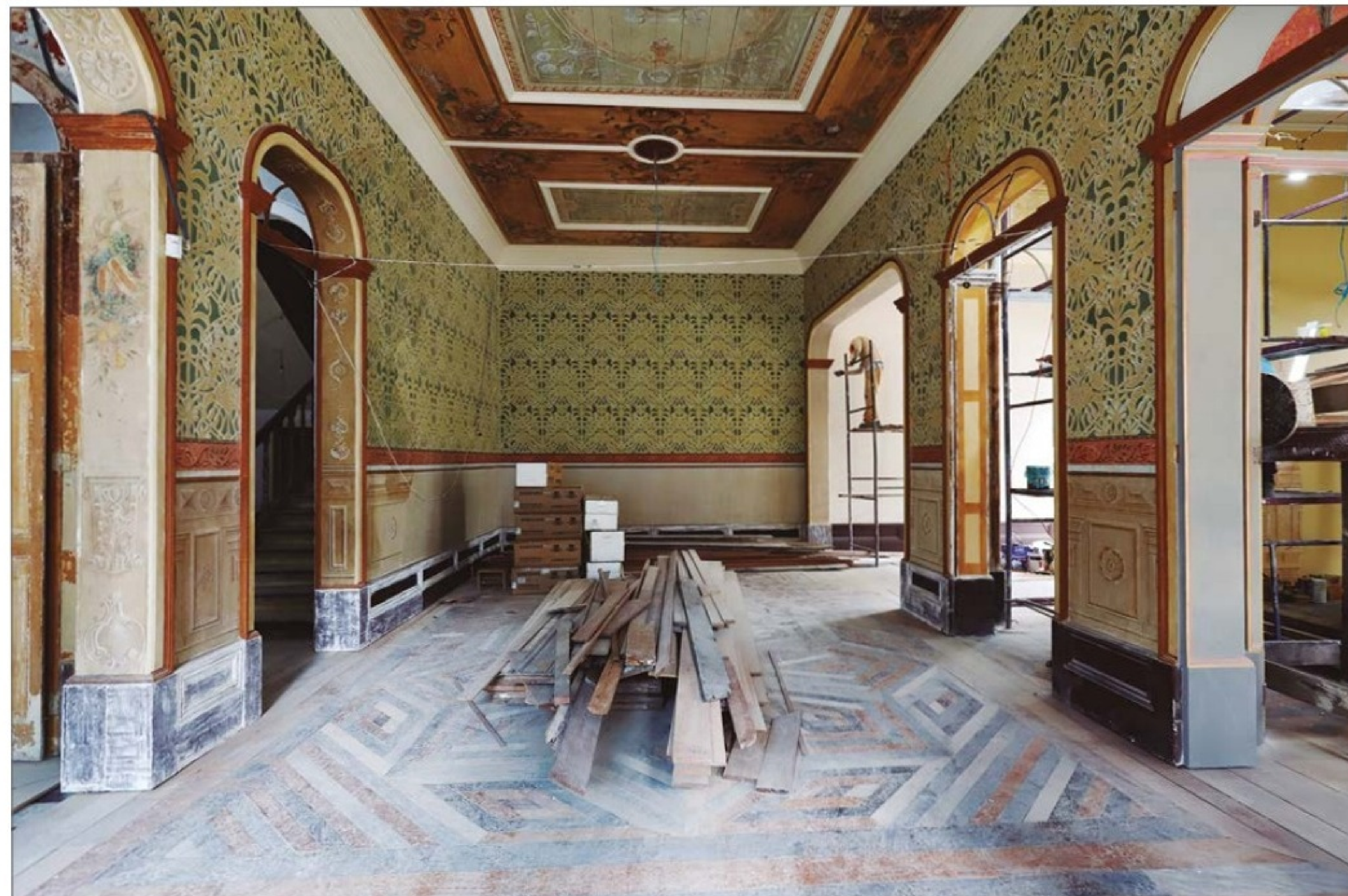
Pinturas artísticas encontradas no local, passíveis de restauração, deixadas aparentes. (OC)
