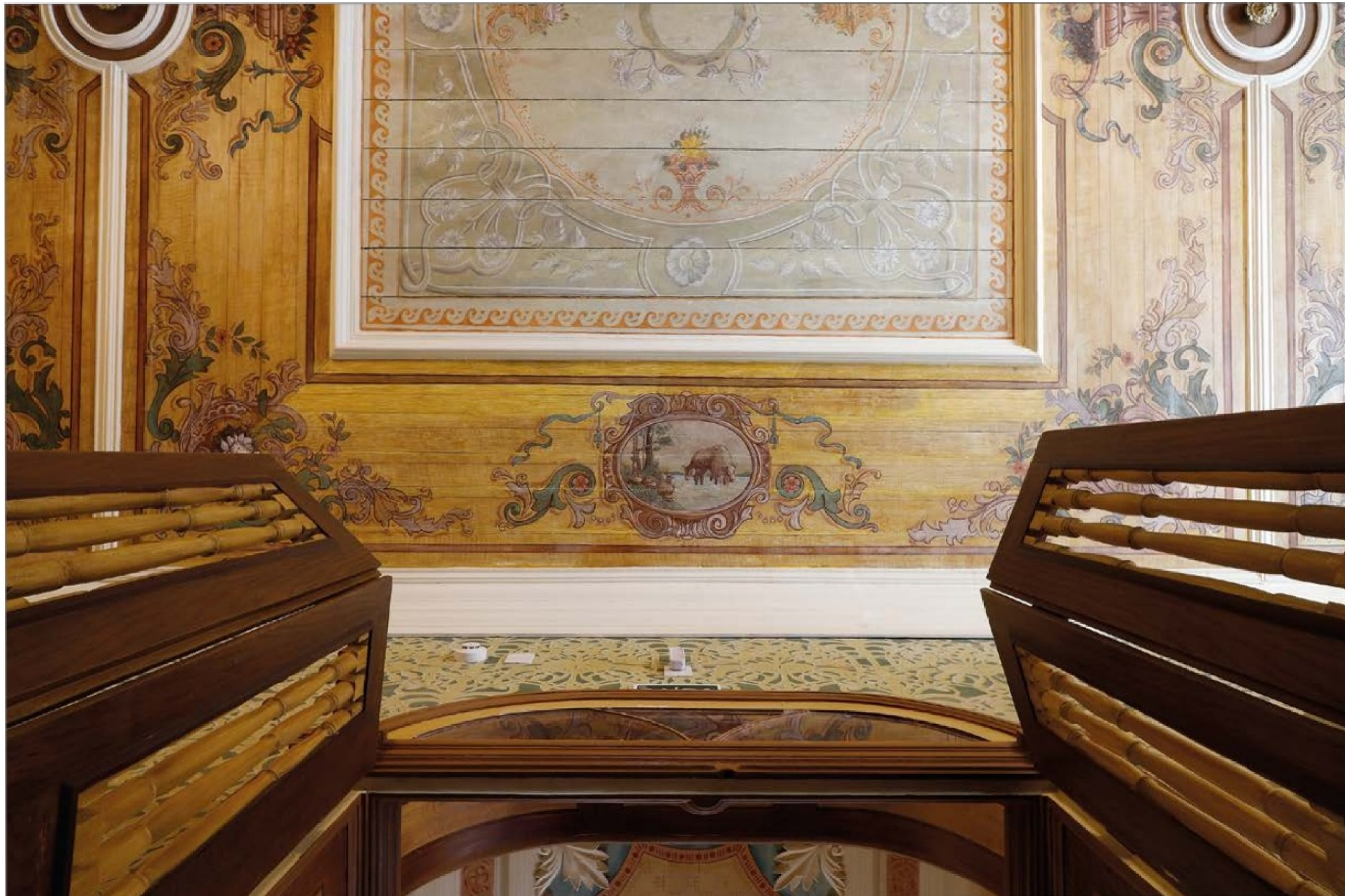
Diversidade de pinturas artísticas encontradas nas paredes, nos forros e nas esquadrias do local. (OC)
