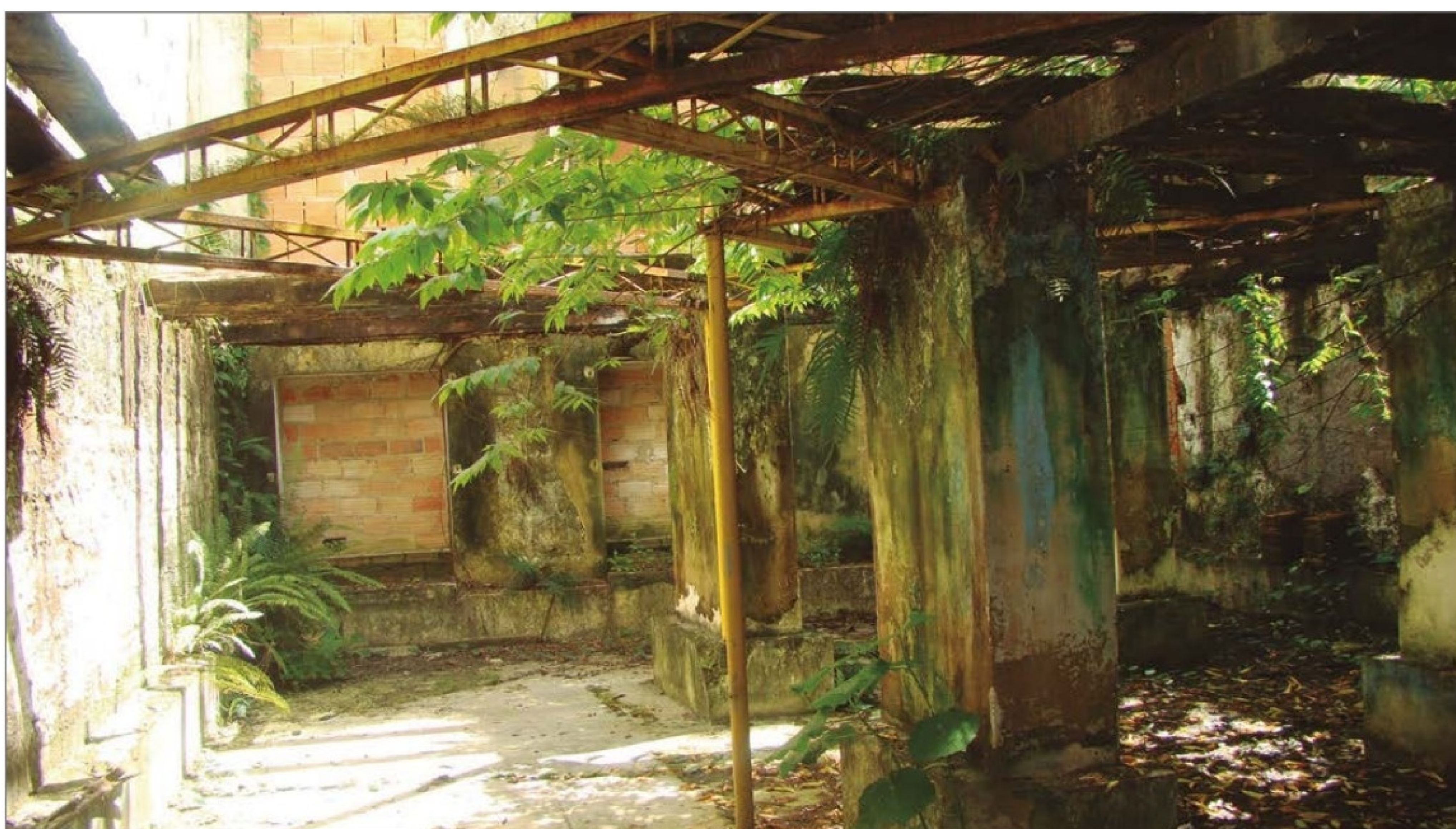
Estado da Casa 03, em 2012, com estruturas metálicas e alvenarias cobertas pela vegetação. (KM)
