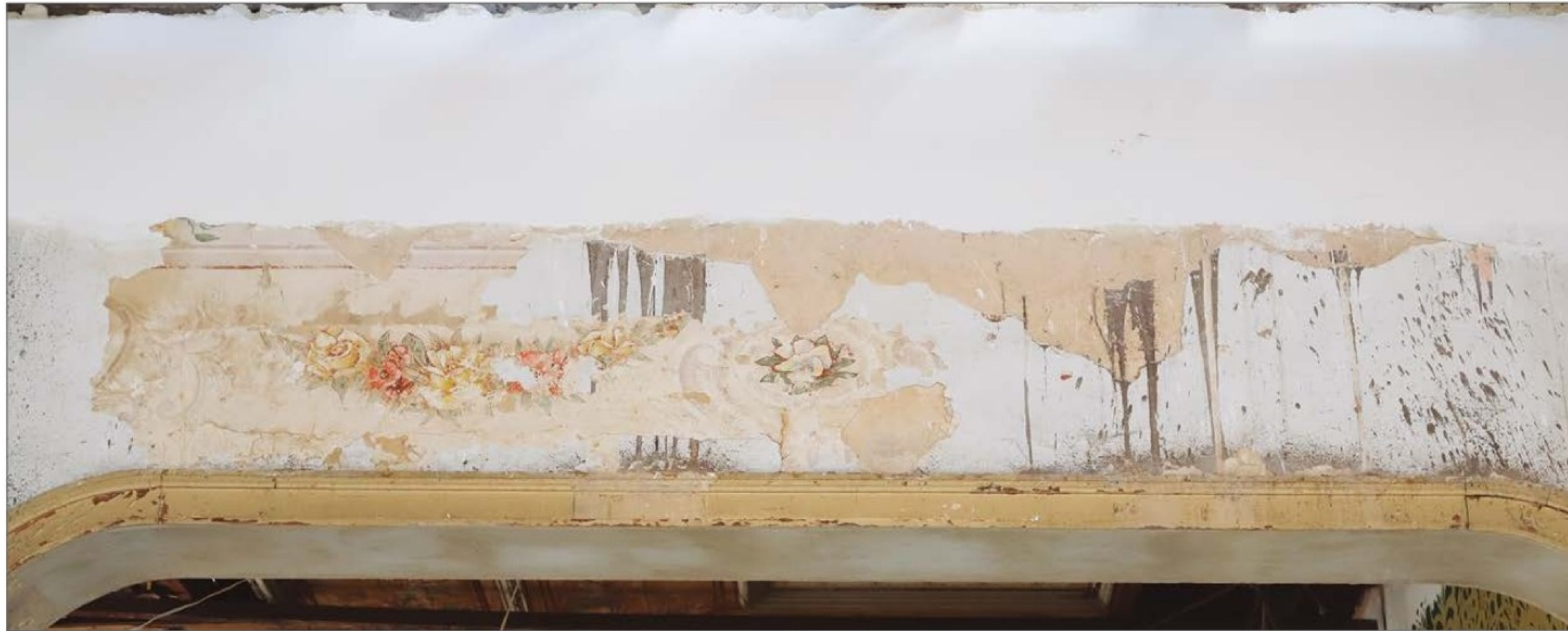
Vestígios de pintura encontrados no único resquício de argamassa original da Sala de Música, onde grande parte do reboco foi substituído durante as obras de reforço estrutural. (OC)
