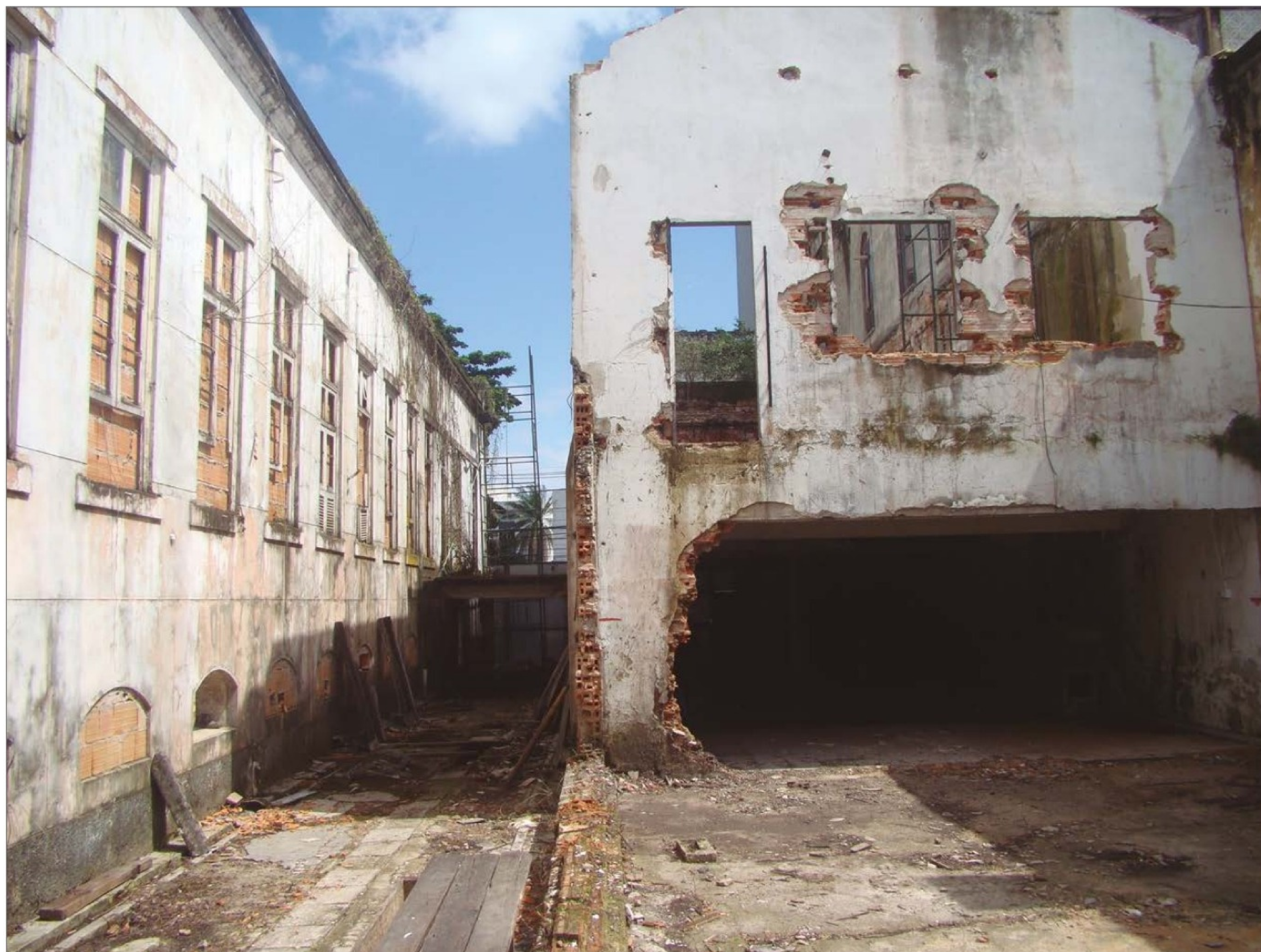
Casas 02 e 03 vistas pelos fundos, em 2016, sem o muro que as separava e com a visível diferença de nível entre os terrenos. (KM)
