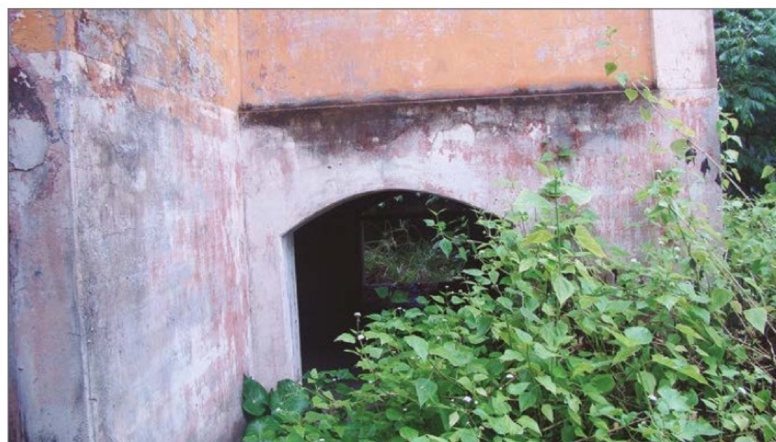
Vista externa do porão do Palacete Faciola, 2012. (AS)
