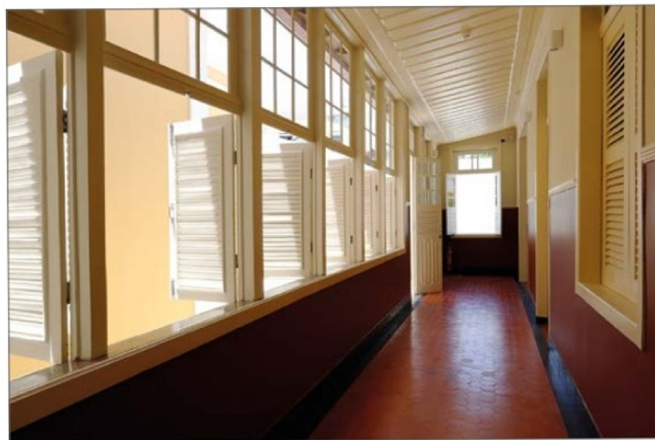
Esquadrias do corredor da área de serviço, restauradas e preservadas em seu lugar. (OC)
