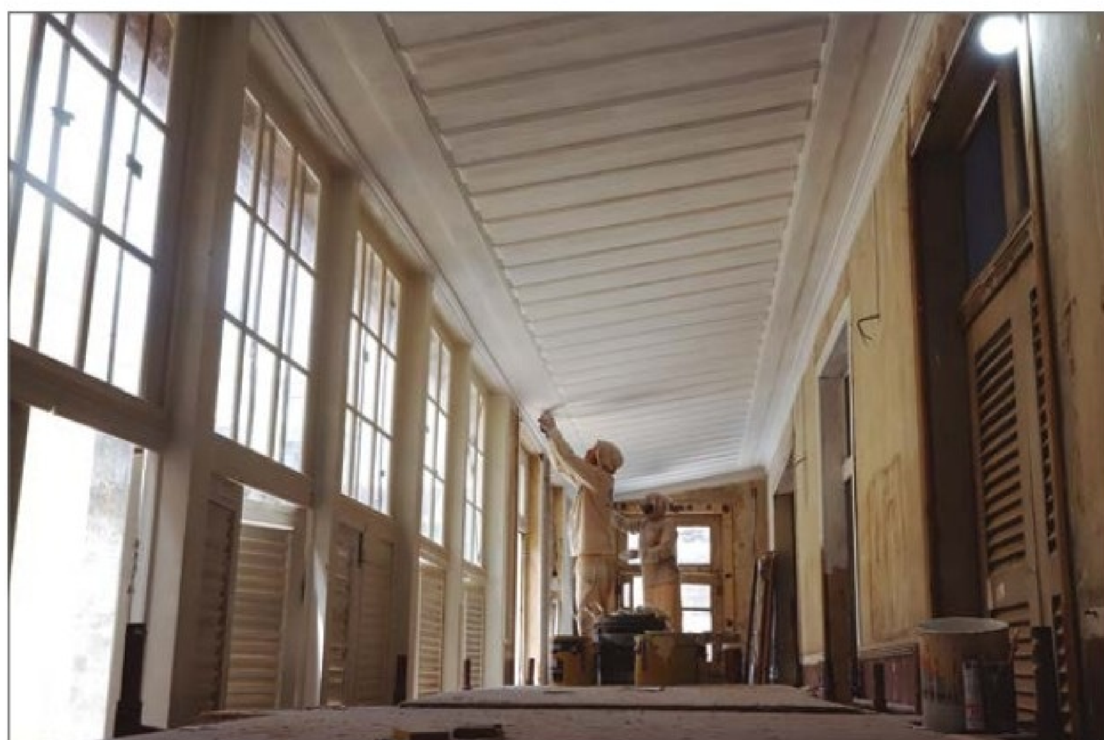
Área de serviço com novo forro de madeira. (OC)
