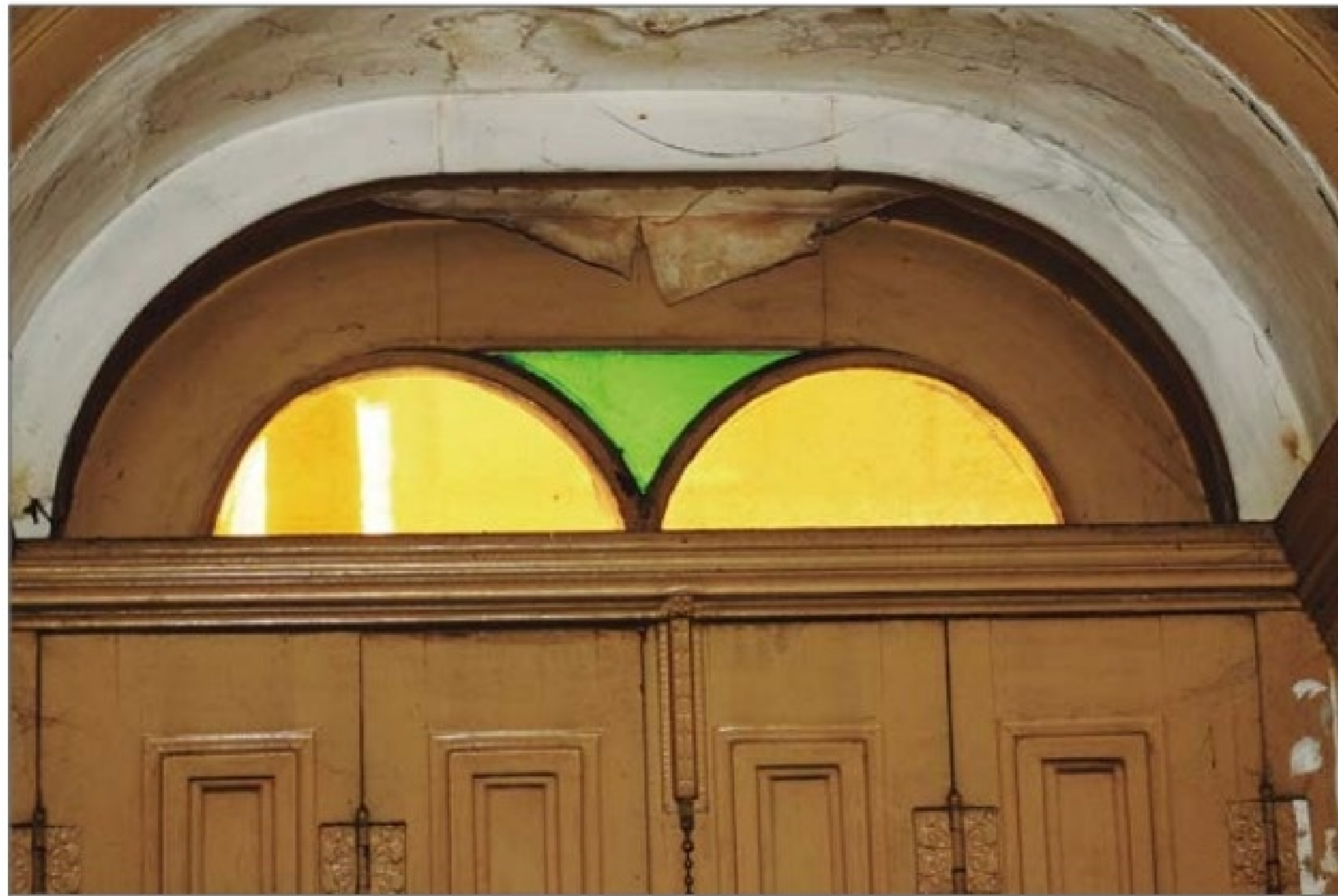
Vidros nas cores verde e amarelo que compunham as bandeiras das esquadrias externas do Palacete. (AS)
