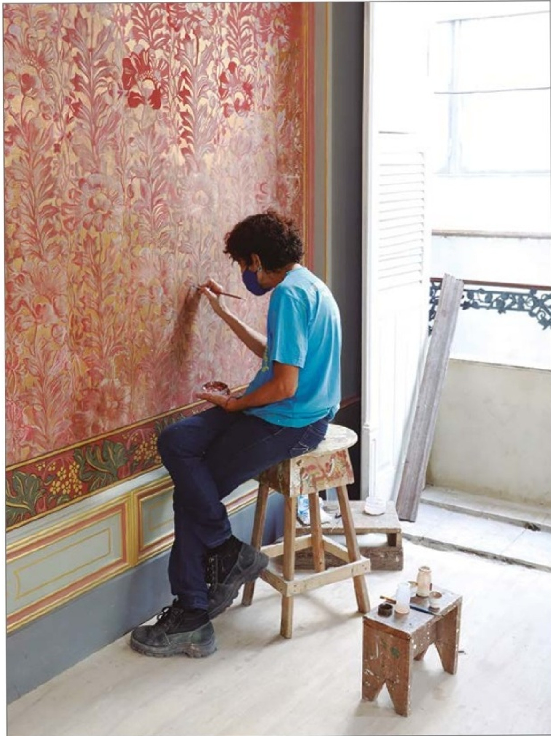
Todas as paredes da Sala Nobre foram restauradas. (OC)
