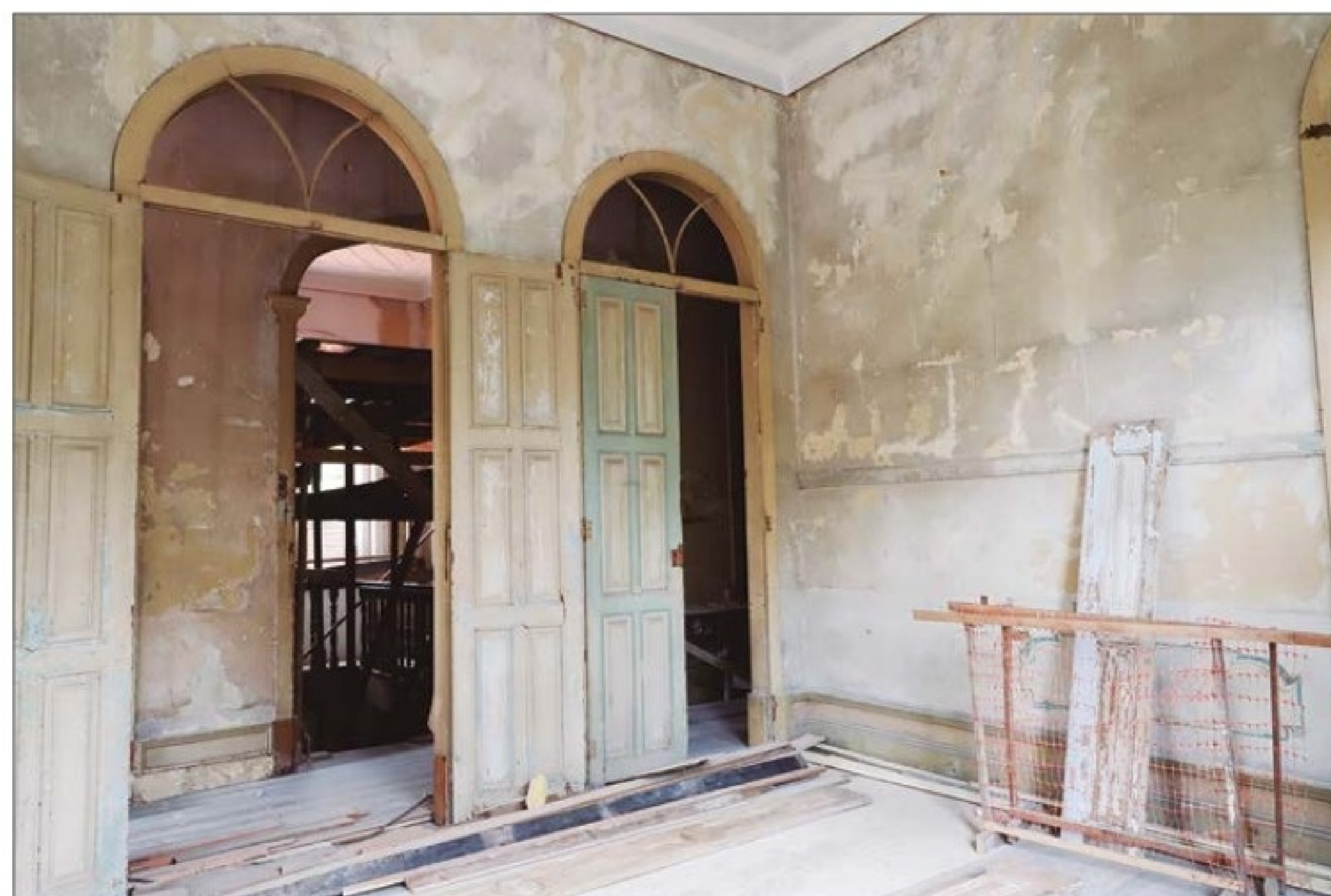
Esquadrias também preservadas. (OC)
