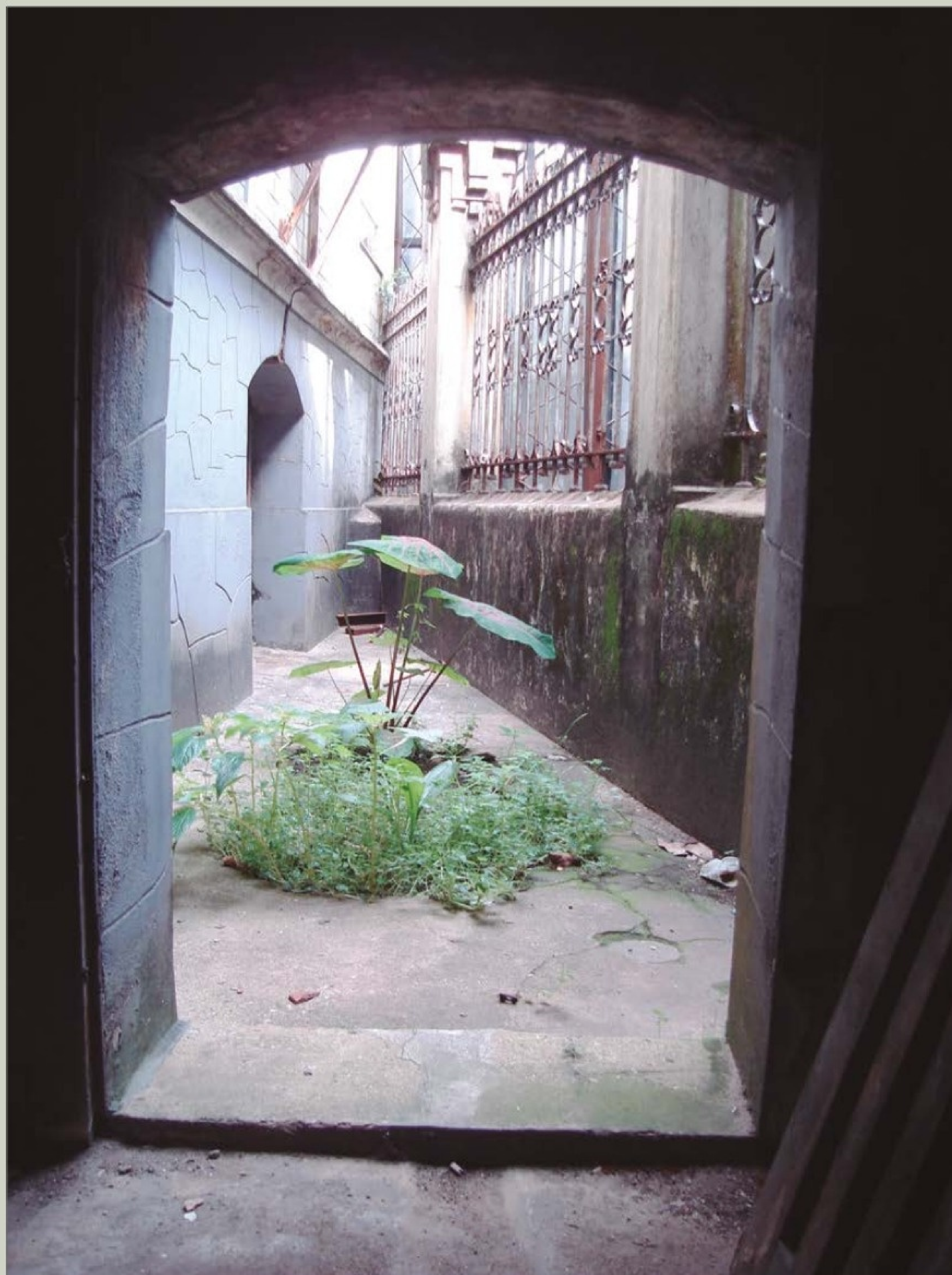
Vista do porão do Palacete Faciola, em direção à esquina do terreno, 2007. (AS)
