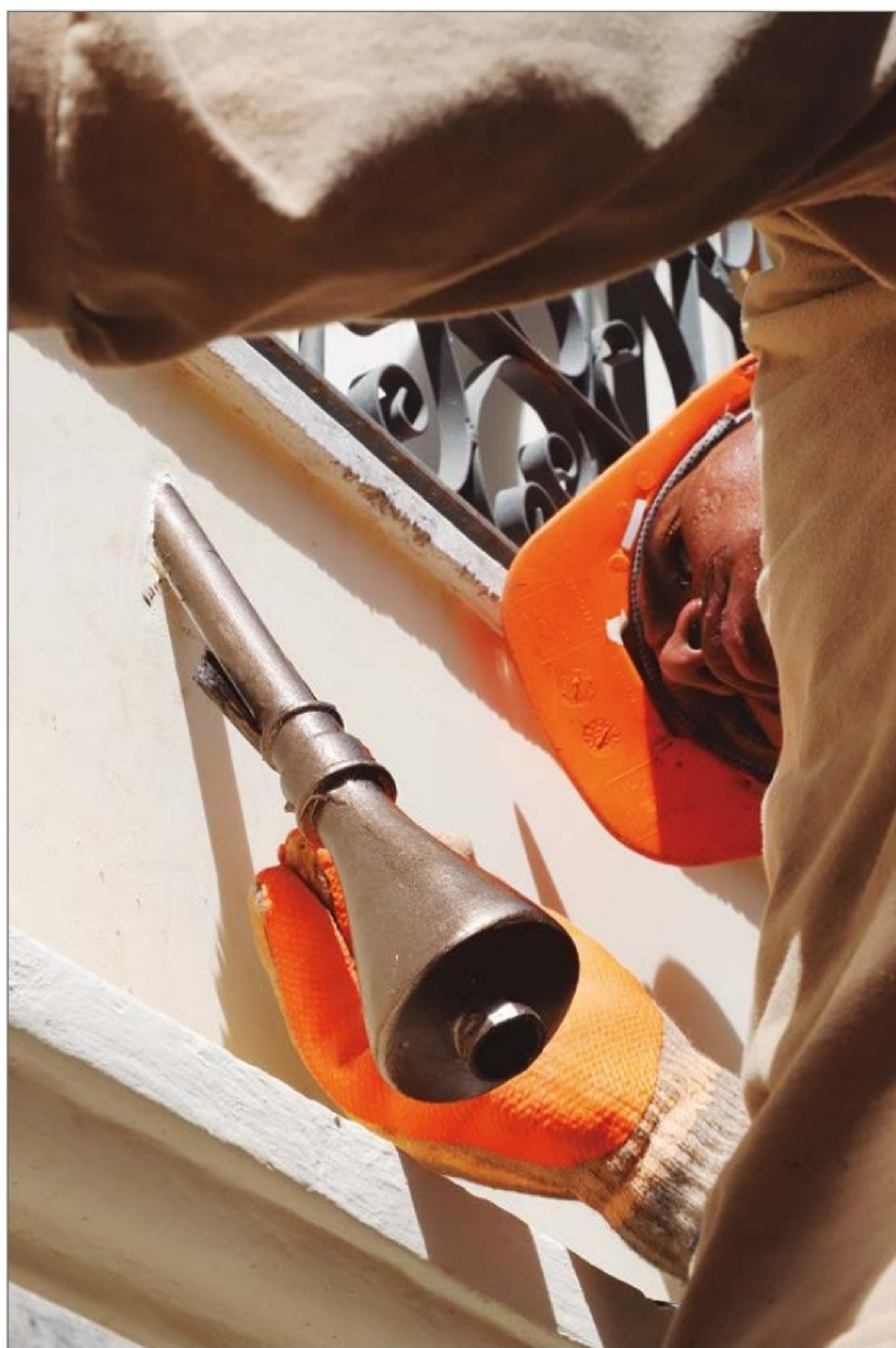
Condutor de água pluvial dos peitoris das janelas (buzinote). (OC)
