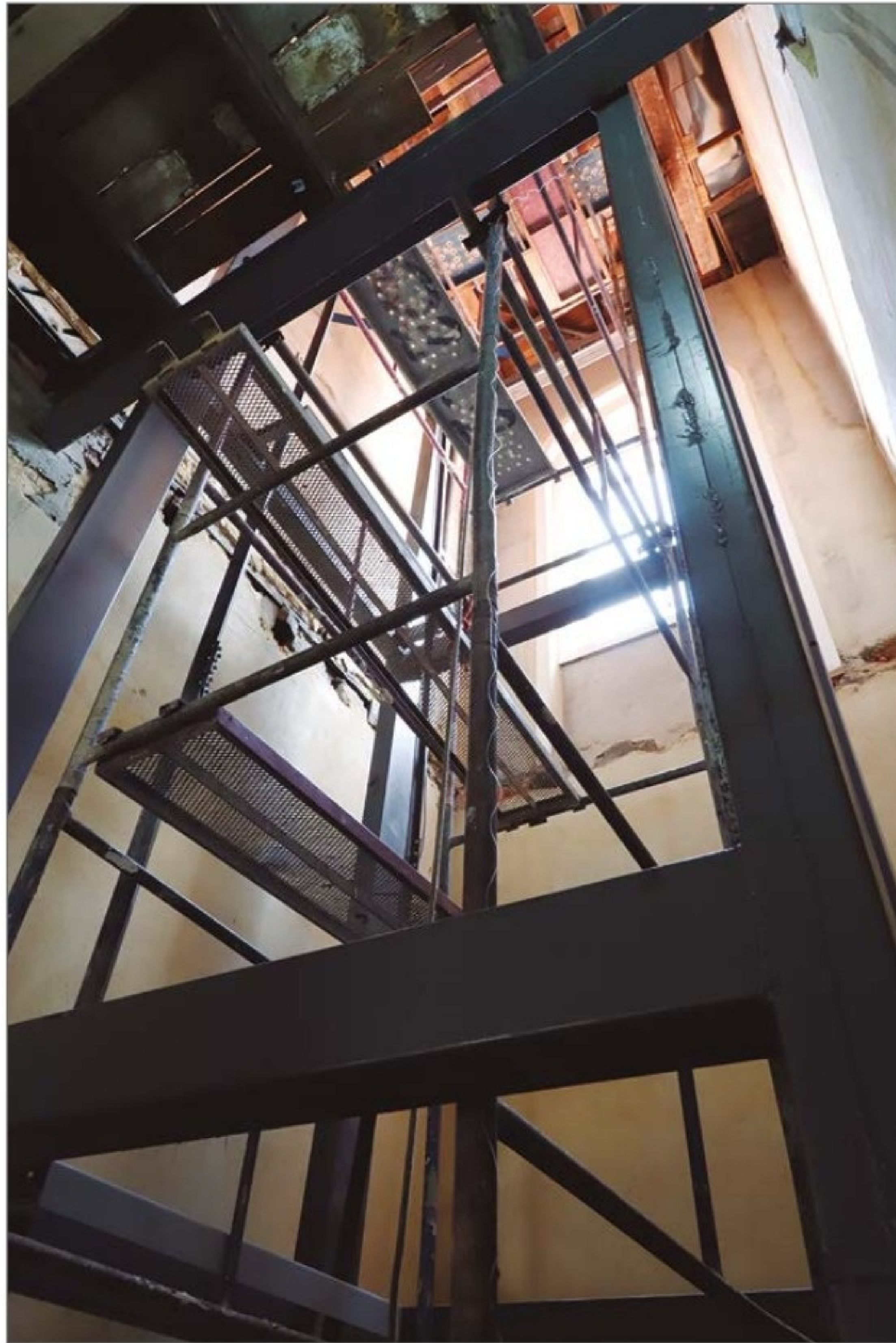
Intervenção no Palacete para a implantação do elevador, melhorando a acessibilidade do prédio. (OC)
