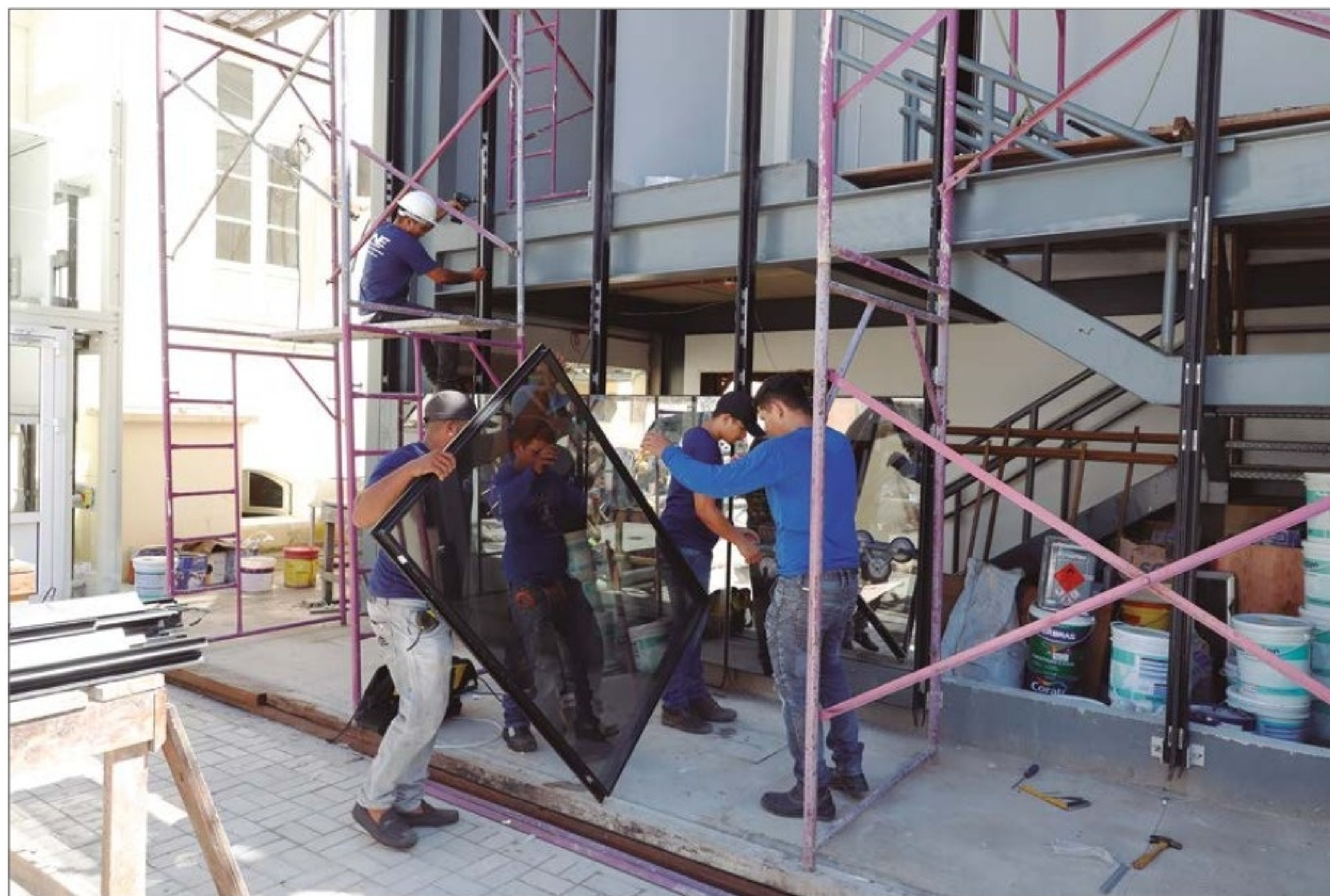
Ampliação da parte posterior da Casa 02, que recebeu uma fachada em pele de vidro. (OC)
