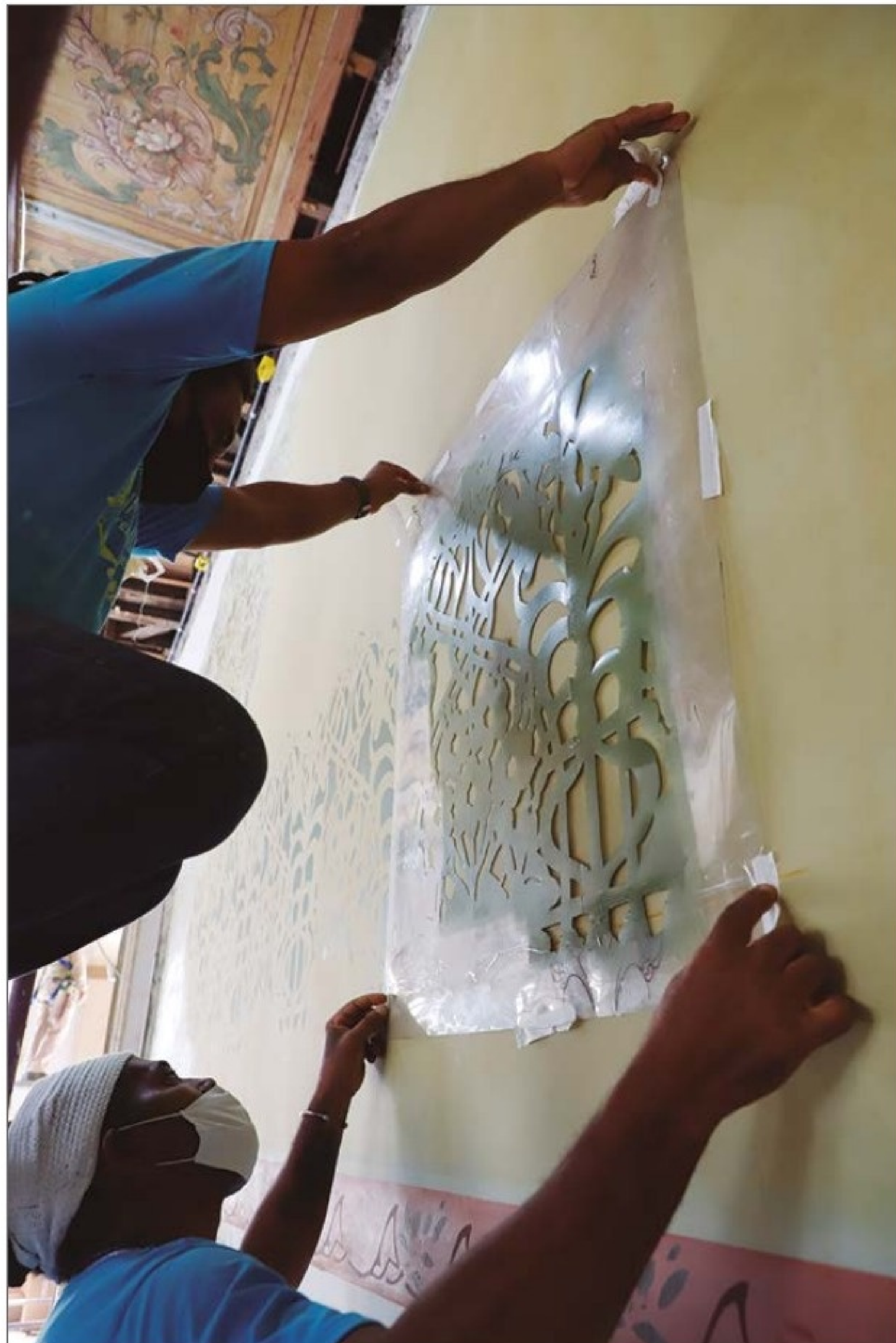
Acabamento das paredes que não tinham mais o desenho original, recriado com a técnica do estêncil, baseada na replicação de um molde. (OC)
