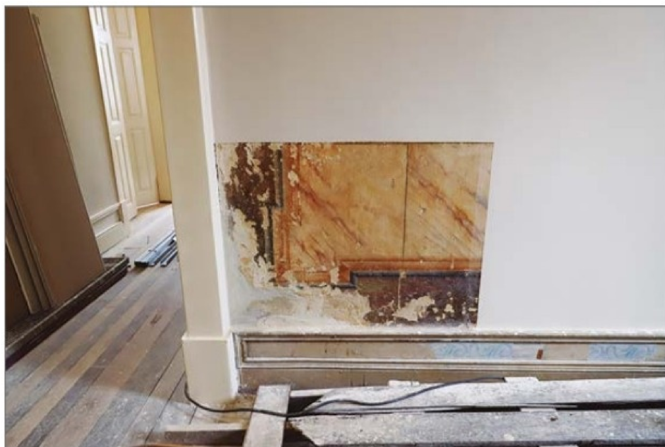
Pintura artística do tipo escaiola encontrada na área da escada. (OC)
