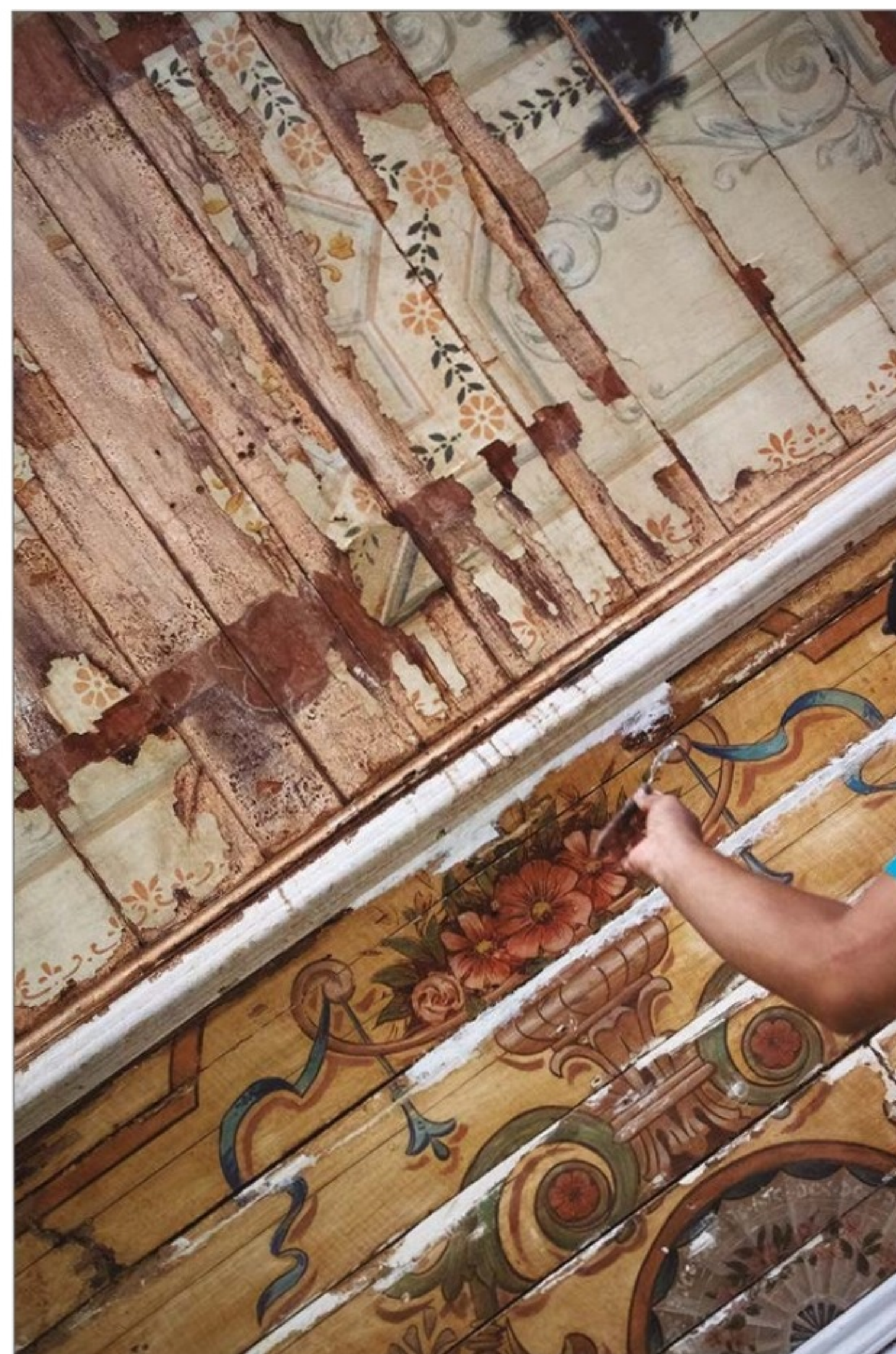
Restauro realizado no forro, cuidadoso e respeitoso. (OC)
