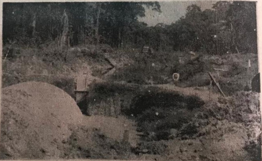
Pela foto verifica-se que a avenida Perimetral ainda não está em plano nivelado ao da ponte e necessário se torna a colocação de picarra e posteriormente asfalto para atingir a meta traçada pelos engenheiros.
