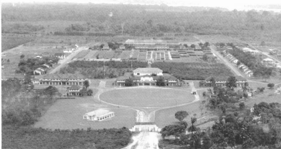
Fig. 6. Vista aérea das principais benfeitorias existentes no campus sede do IAN, em Belém, PA.
