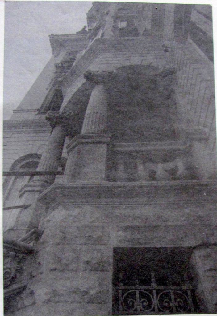
Lateral pela Vila do Palacete Bolonha. Vê-se os capitéis das colunas decorados com flores, no caso rosas, não tem folhas de acauto. Em baixo vê-se a janela do quarto dos empregados que dá para a Vila.
