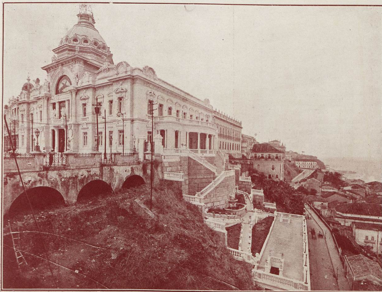
PALACIO RIO BRANCO — LATERAL DO LADO DO MAR — (PHOTOGRAPHIA DA OBRA INEDITA — BAHIA HISTORICA — DE SILIO BOCANERA JUNIOR)
